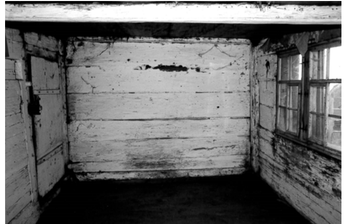
18 Wattwil-Egeten: Blick in eine der schlichten Kammern im Obergeschoss kurz vor den Abbauarbeiten. Aufnahme 1986.
