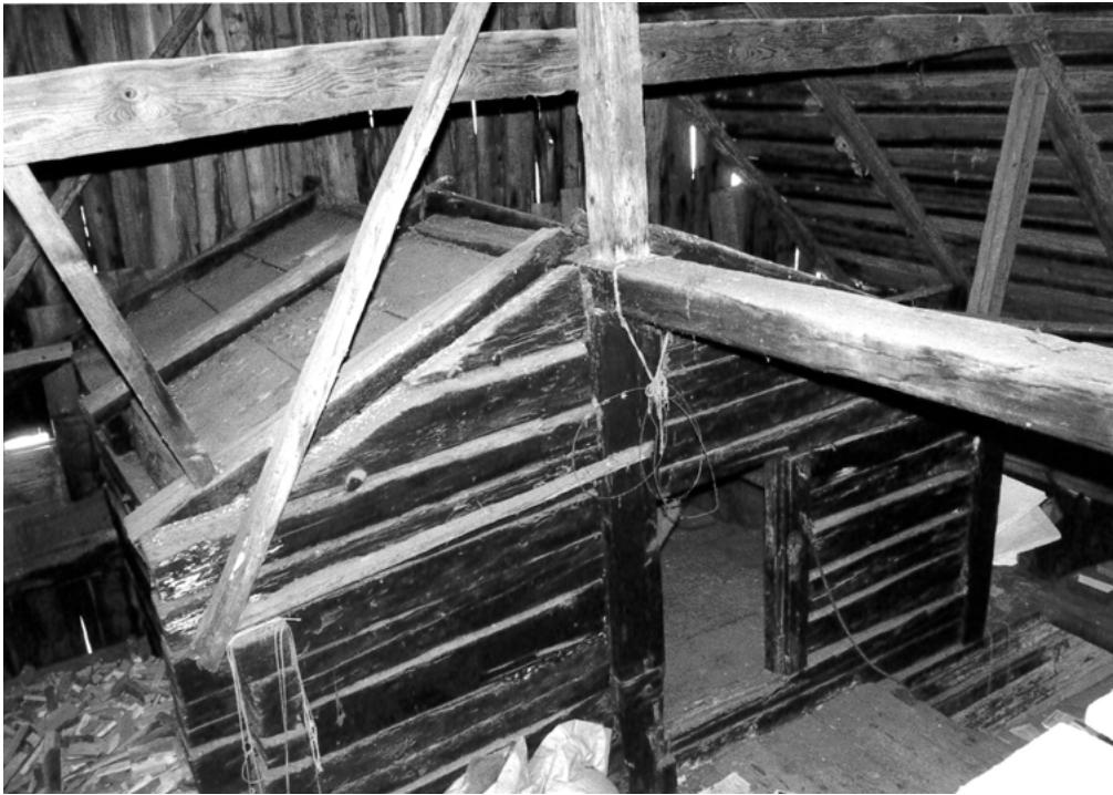
8 Wattwil-Egeten: Die spätmittelalterliche Dachkammer und die darin eingebundene, einstige Firstpfette blieben trotz der Veränderung des Daches im 18. Jahrhundert erhalten. Die ursprüngliche flachere Dachneigung ist unschwer zu beobachten. Bemerkenswert ist, dass auch die Dachkammer in einer Mischkonstruktion aus Block- und Ständerbauweise errichtet wurde. Blick nach Norden. Aufnahme 1986.
