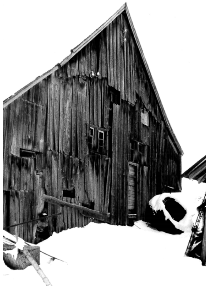
11 Wattwil-Egeten: Die rückwärtige, nach Nordwesten orientierte Giebelfassade war zum Zeitpunkt des Abbaus mit einem Witterungsschutz aus einfachen Brettern versehen. Aufnahme 1986.
