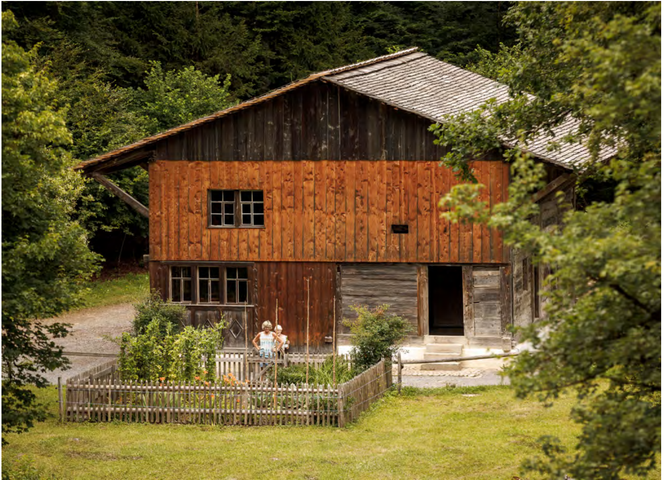
21 Freilichtmuseum der Schweiz, Wohnhaus aus Wattwil-Egeten: Zum Schutz der mittelalterlichen Bausubstanz wurde die Hauptgiebelfront 2013 nachträglich teilweise mit einer Bretterschulung versehen. Blick nach Norden. Aufnahme 2017.
