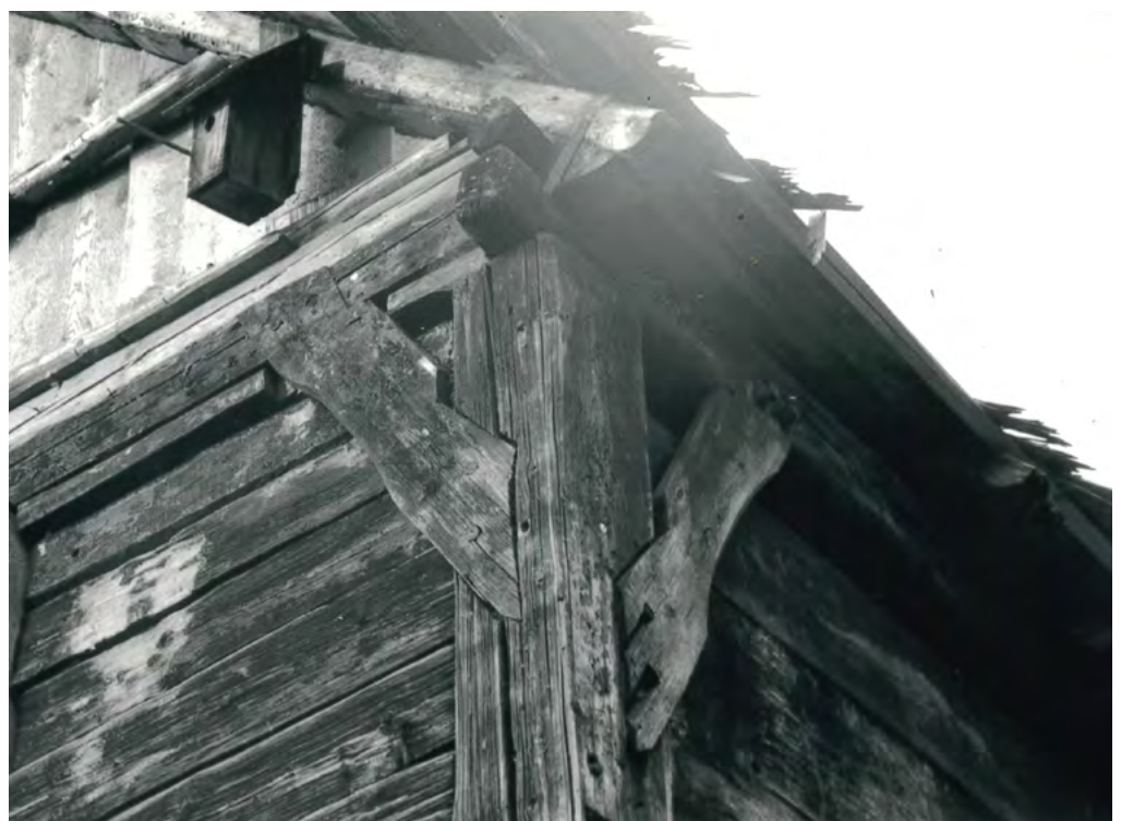
6 Wattwil-Egeten: Detailansicht der rückwärtigen Nordfassade. Gut sichtbar ist die interessante Kombination von Blockbauweise im Erdgeschoss und Ständerbauweise im Obergeschoss. Aufnahme 1986.
