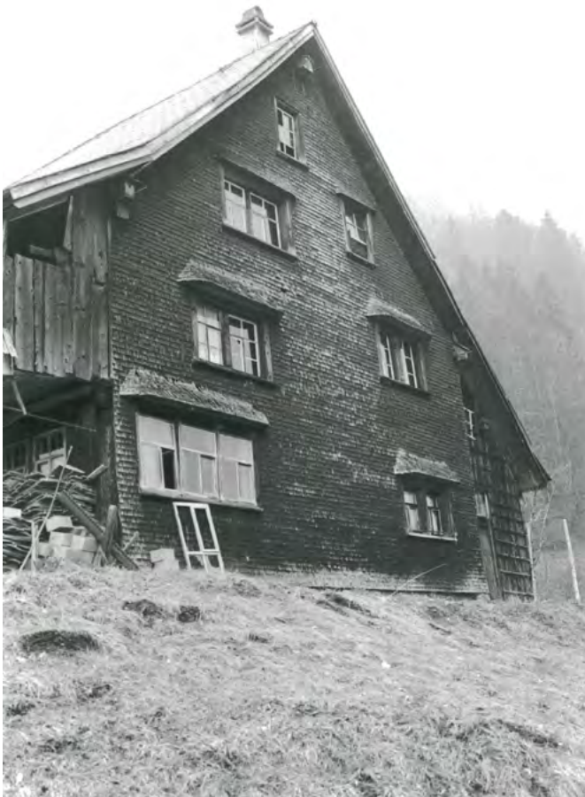
9 Wattwil-Egeten: Die zum Tal gerichtete Hauptfassade wurde nachträglich mit einem flächigen Schindelschirm versehen, der sich durch kräftige Abwürfe über den Fenstern auszeichnete. Diese sind für die Region typisch. Aufnahme 1985.
