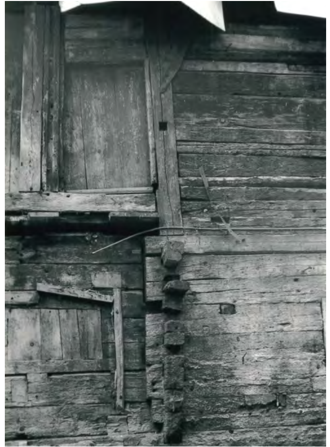
6 Wattwil-Egeten: Detailansicht der rückwärtigen Nordfassade. Gut sichtbar ist die interessante Kombination von Blockbauweise im Erdgeschoss und Ständerbauweise im Obergeschoss. Aufnahme 1986.
