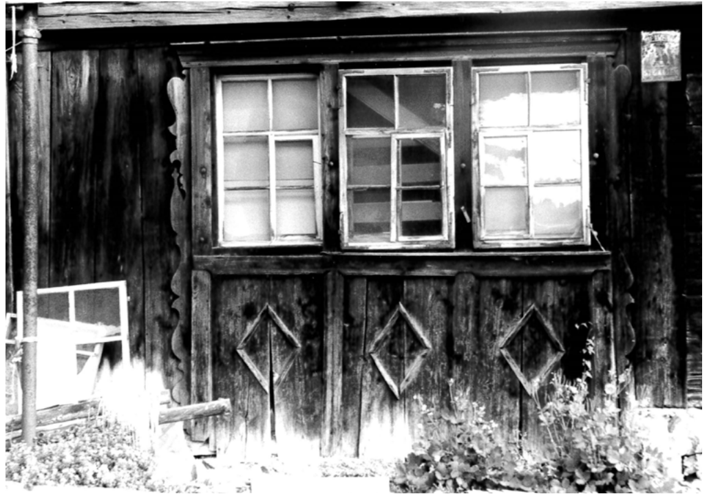
10 Wattwil-Egeten: Detailansicht der Stubenfront in der Südfassade. Hier haben sich am Reihenfenster – geschützt durch spätere Anbauten – die barocken Zugläden aus dem 18. Jahrhundert erhalten. Aufnahme 1986.
