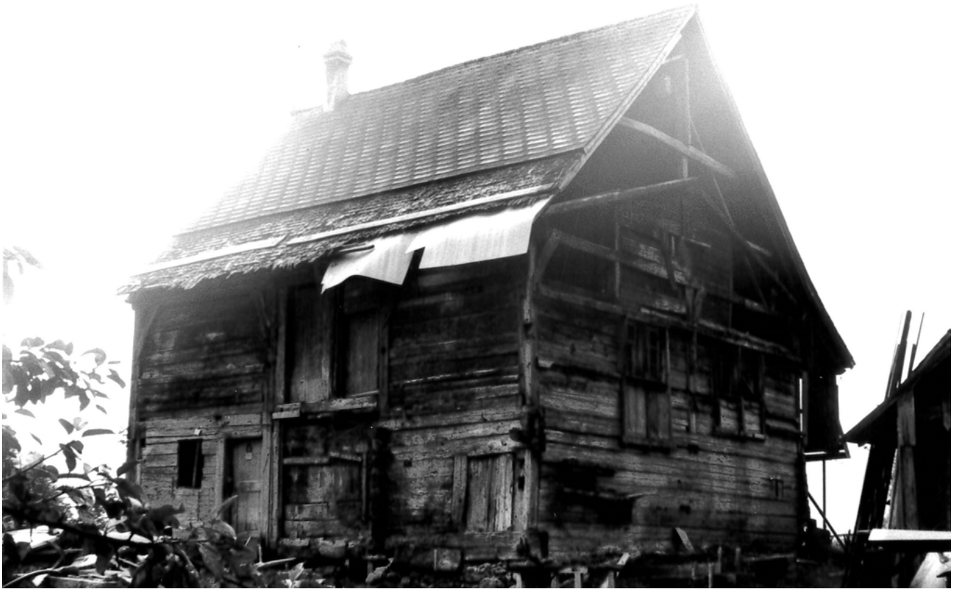
20 Wattwil-Egeten: Das Haus während der Abbauarbeiten. Sichtbar wurde zu diesem Zeitpunkt der heterogene Erhaltungszustand des mittelalterlichen Kernbaus. Blick nach Norden. Aufnahme 1986.
