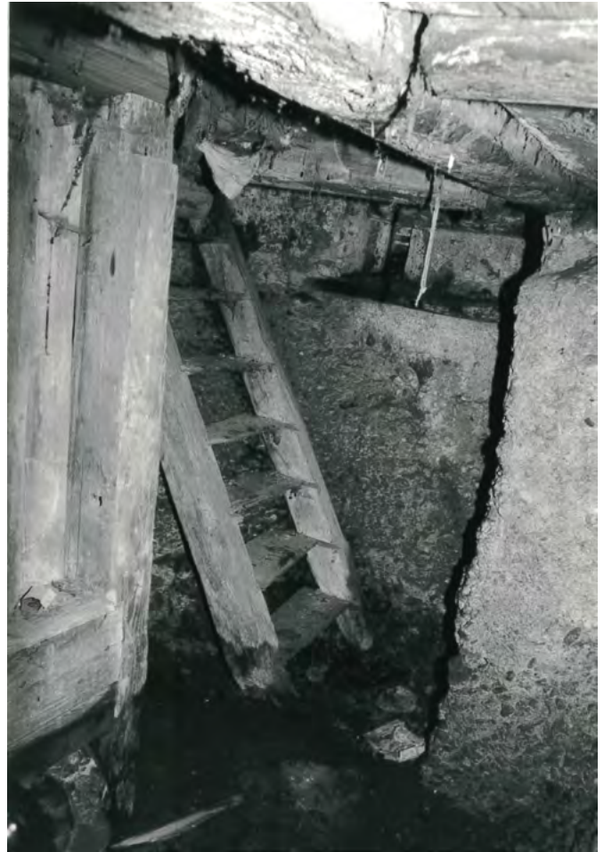
14 Wattwil-Egeten: Webkeller. Die Kellerwände lassen erkennen, dass der Raum in den anstehenden Nagelfluhfelsen getrieben wurde, was sicherlich einen erheblichen Aufwand bedeutet hatte. Das Aufmauern von Kellerwänden hingegen entfiel weitestgehend. Aufnahme 1986.
