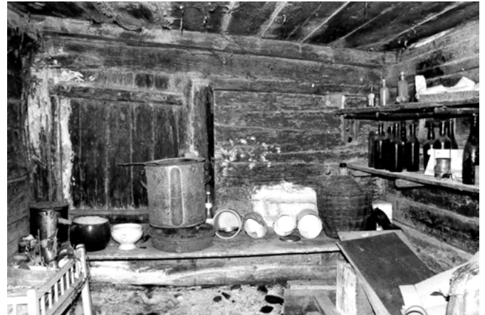
16 Wattwil-Egeten: Der erdgeschossige Keller- beziehungsweise Vorratsraum befand sich in der Nordwestecke des Baus. Aufnahme 1986.
