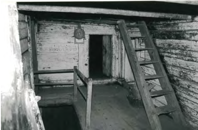
17 Wattwil-Egeten: Blick in die Erschliessungszone im Obergeschoss kurz vor den Abbauarbeiten. Aufnahme 1986.
