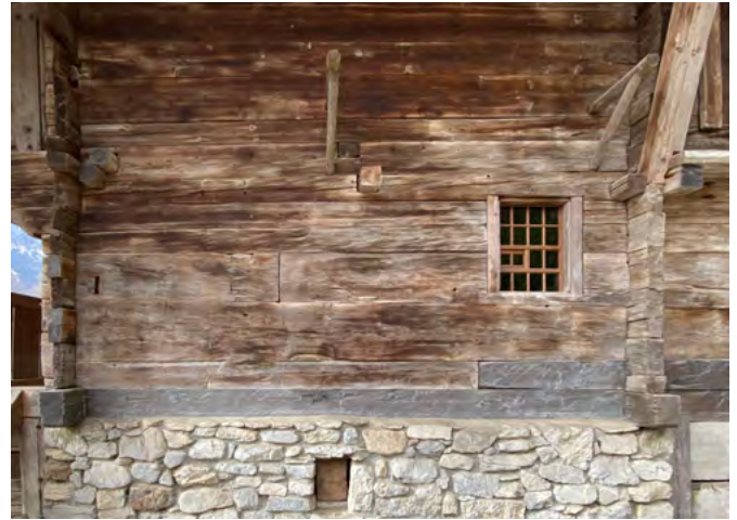
12 Freilichtmuseum der Schweiz, Bauernhaus aus Adelboden: Rückseite des Ballenberghauses mit ungewöhnlich gefügten Wandflecken und seltsamen Durchbrüchen von Deckenbalken. Blick nach Südwesten. Aufnahme 2022.
