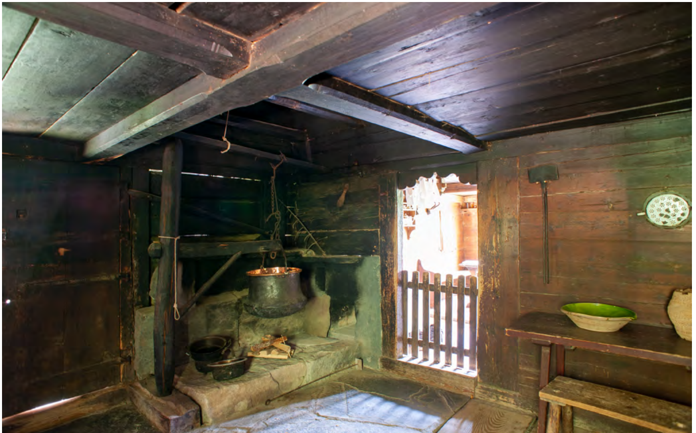
30 Freilichtmuseum der Schweiz, Bauernhaus aus Adelboden: Die Öffnung des Bretterkamins nimmt zirka ein Viertel der Deckenfläche in Anspruch und befindet sich direkt über der Feuerstelle mit Turner und Käsekessel. Blick nach Süden. Aufnahme 2020.
