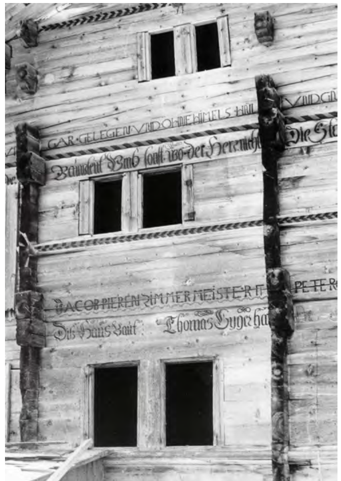
15 Adelboden, Bunderlen: Blick auf die talseitige Giebfassade während dem Rückbau des Hauses in Adelboden. Blick nach Südosten. Aufnahme 1967/1968.
