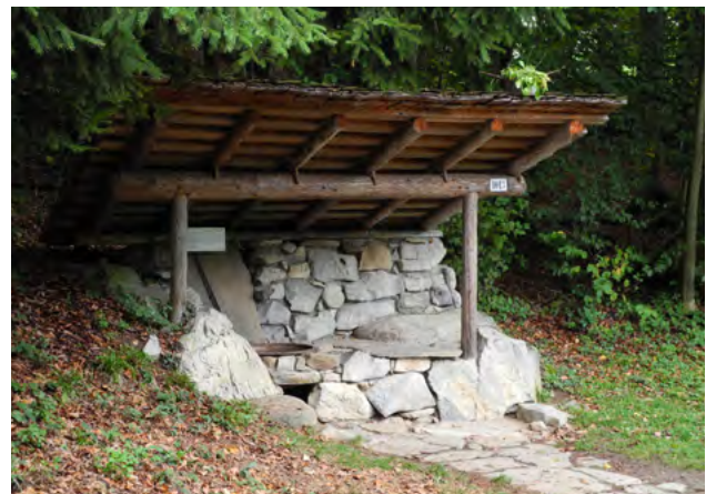
27 Freilichtmuseum Ballenberg, Blackensiede: Die Blackensiede beim Bauernhaus aus Adelboden ist eine Rekonstruktion. Häufig wurden die Herdstellen auch für das Waschen der Wäsche genutzt und waren daher in der Nähe eines Brunnens aufgestellt. Blick nach Osten. Aufnahme 2013.
