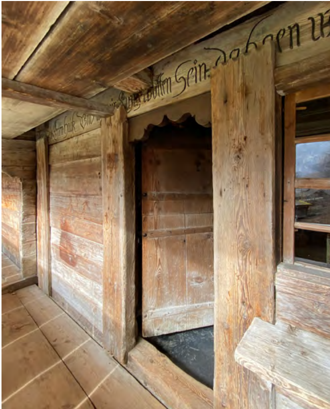
11 Freilichtmuseum der Schweiz, Bauernhaus aus Adelboden: Durchstossender Deckenbalken über dem Hauseingang. Im Hintergrund bei der Vergwättung ist der Ständer im Küchenbereich erkennbar. Blick nach Westen. Aufnahme 2022.
