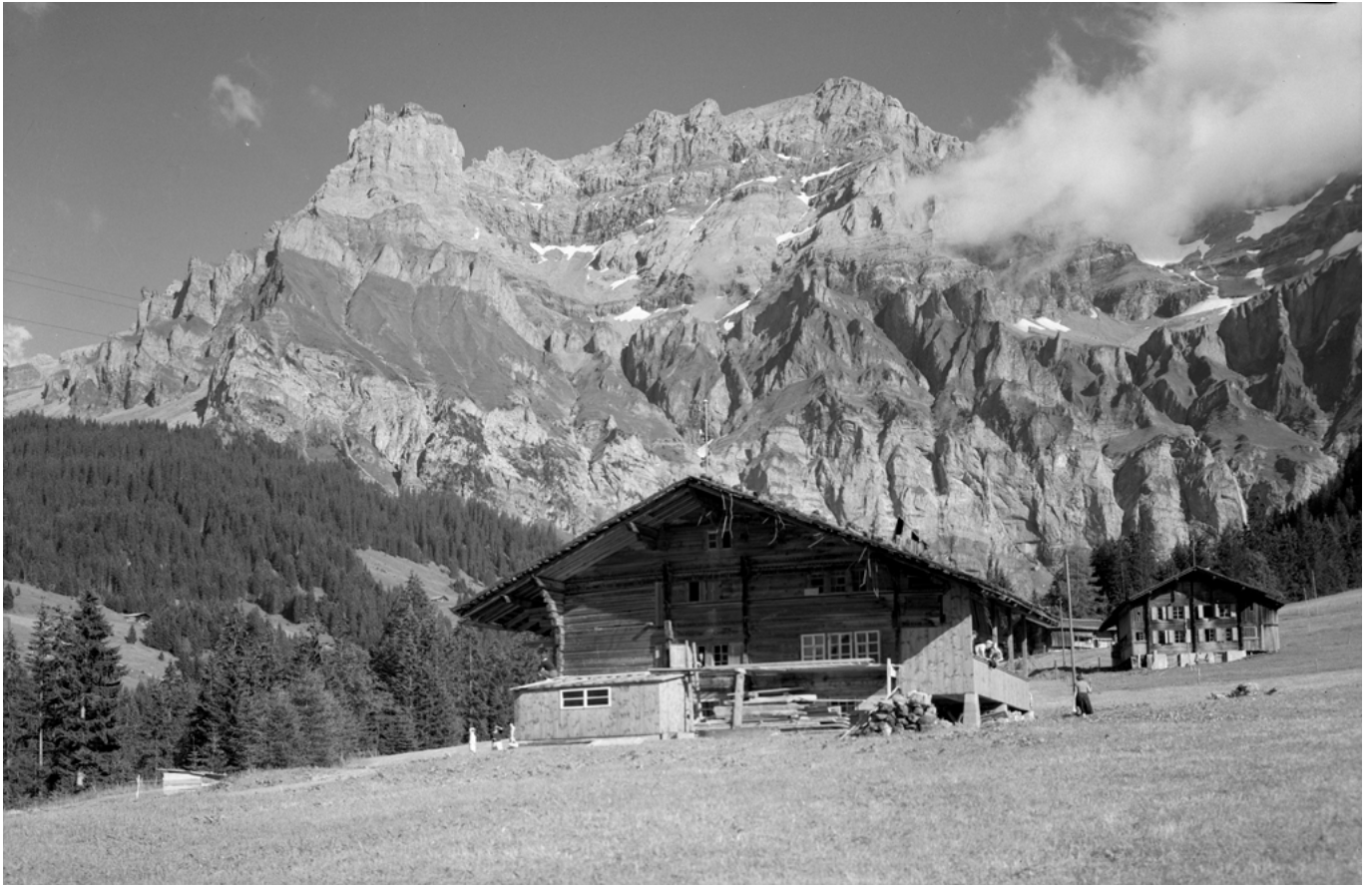
14 Adelboden, Bonderten: Gut sichtbare bauliche Veränderungen im Bereich der Laube und des angebauten Schopfs. Blick nach Südosten. Aufnahme nach 1955.
