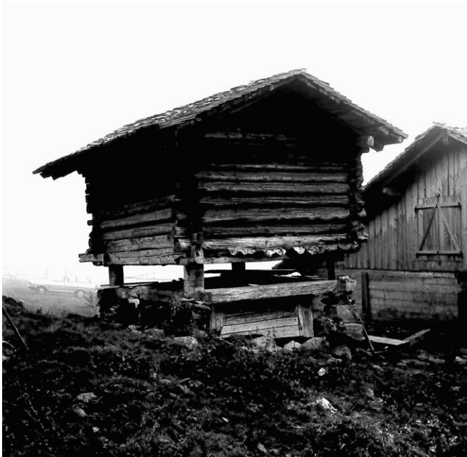
12 Lütschentäl, Alp Hintisberg, Unterläger: Die Rückseite und Nordfassade des Speichers. Der Bereich unter dem Schwellenkranz wurde als Lagerfläche genutzt. Blick nach Südosten. Aufnahme vor 1979.
