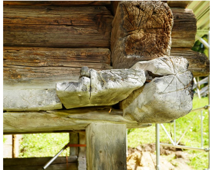
11 Freilichtmuseum der Schweiz, Käsespeicher aus Lütschental: Die Holzelemente, welche mit Salzwasser in Berührung gekommen sind, heben sich farblich deutlich von den anderen ab. Blick nach Nordosten. Aufnahme 2022.
