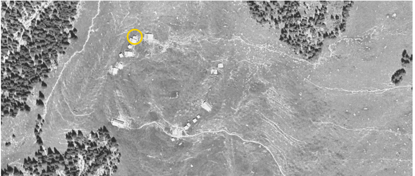
4 Lüttschental, Alp Hintisberg, Unterläger: In der ersten Hälfte des 20. Jahrhunderts präsentiert sich der mittlere Stafel noch als Alpdorf mit mehreren Sennhütten und Speicherbauten. Der frühere Standort des translozierten Speichers ist eingekreist. Aufnahme 1940.
