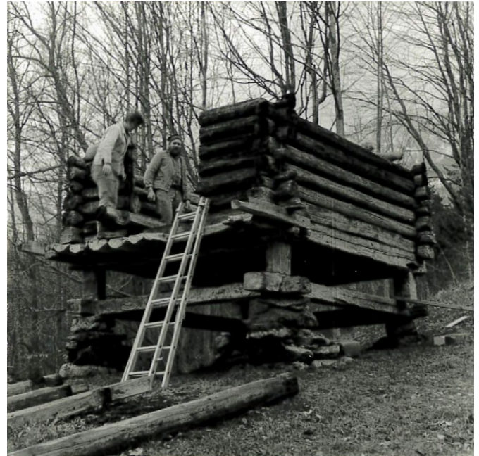
17 Freilichtmuseum der Schweiz, Käsespeicher aus Lütschental: Auf die vier Eckfundamente aus geschichteten Feldsteinen wurde der hölzerne Baukörper Lage für Lage wiederaufgebaut. Es wurde darauf geachtet, dass alle Elemente wieder an ihre ursprüngliche Position gelangten. Blick nach Norden. Aufnahme 1978/79.
