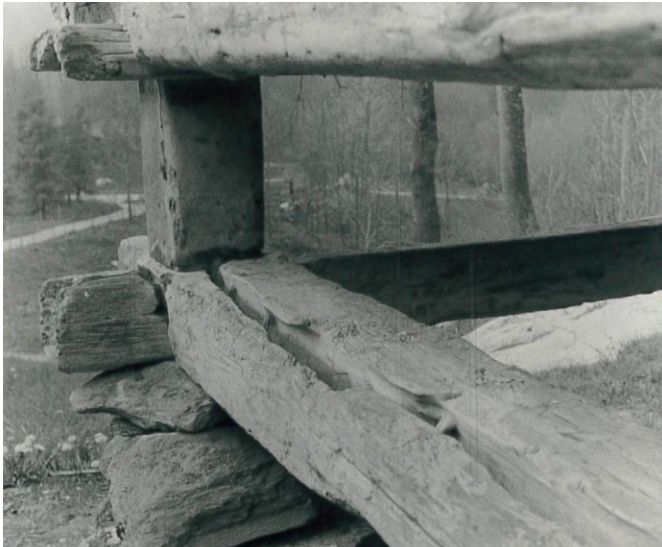
10 Freilichtmuseum der Schweiz, Käsespeicher aus Lütschental: Die Rinne im unteren Schwellenkrans entstand wohl durch herabtropfendes Salzwasser von der Käsepflege im Speicher, welches von den Tieren aufgeleckt wurde. Blick nach Westen. Aufnahme undatiert.
