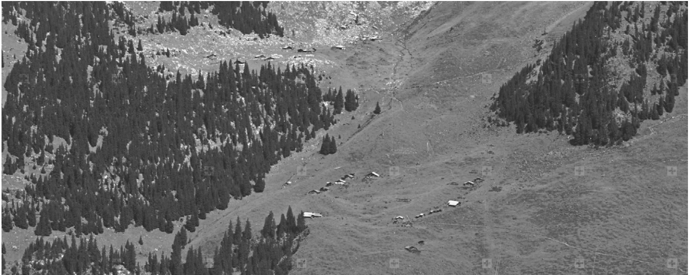
8 Lütschental, Alp Hintisberg, Ober- und Unterläger: Der translozierte Speicher der Alp Hintisberg befindet sich auf dem Mittelstafel mit dem Flurnamen Spycheregg. Blick nach Nordwesten. Aufnahme 1926.
