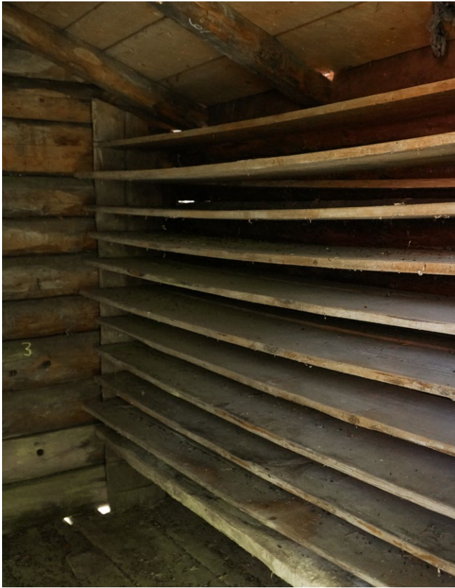
14 Freilichtmuseum der Schweiz, Käsespeicher aus Lütschental: Die Käseregale sind denkbar einfach konstruiert. Ein Hälbling mit Nuten in regelmässigen Abständen trägt die Regalbretter. Blick nach Osten. Aufnahme 2022.
