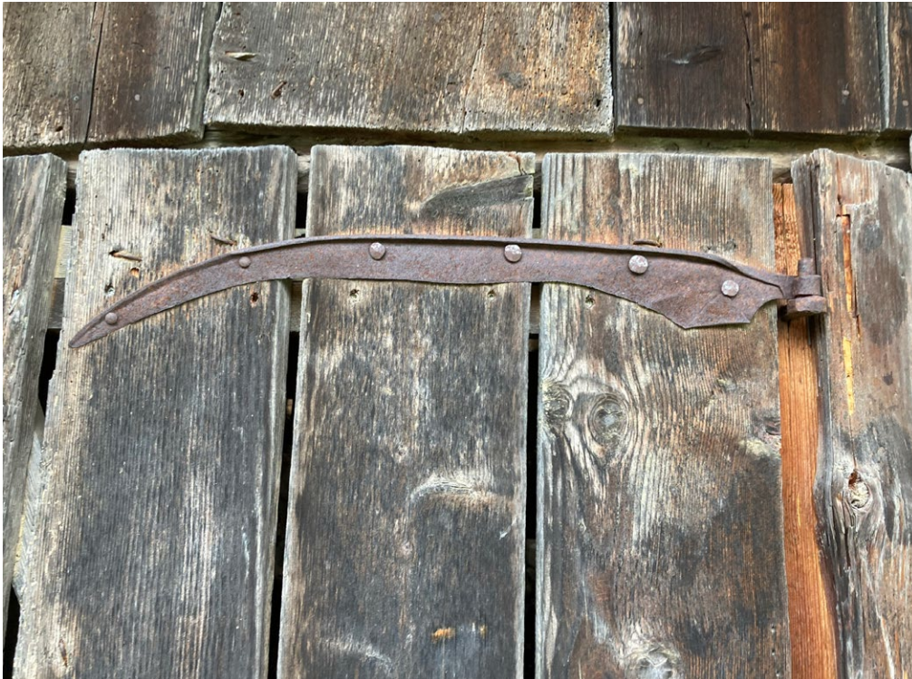
22 Freilichtmuseum der Schweiz, Heustall aus Brienzwiler: Als Türband am Anbau dienen ausrangierte Sensenblätter. Blick nach Norden. Aufnahme 2021.
