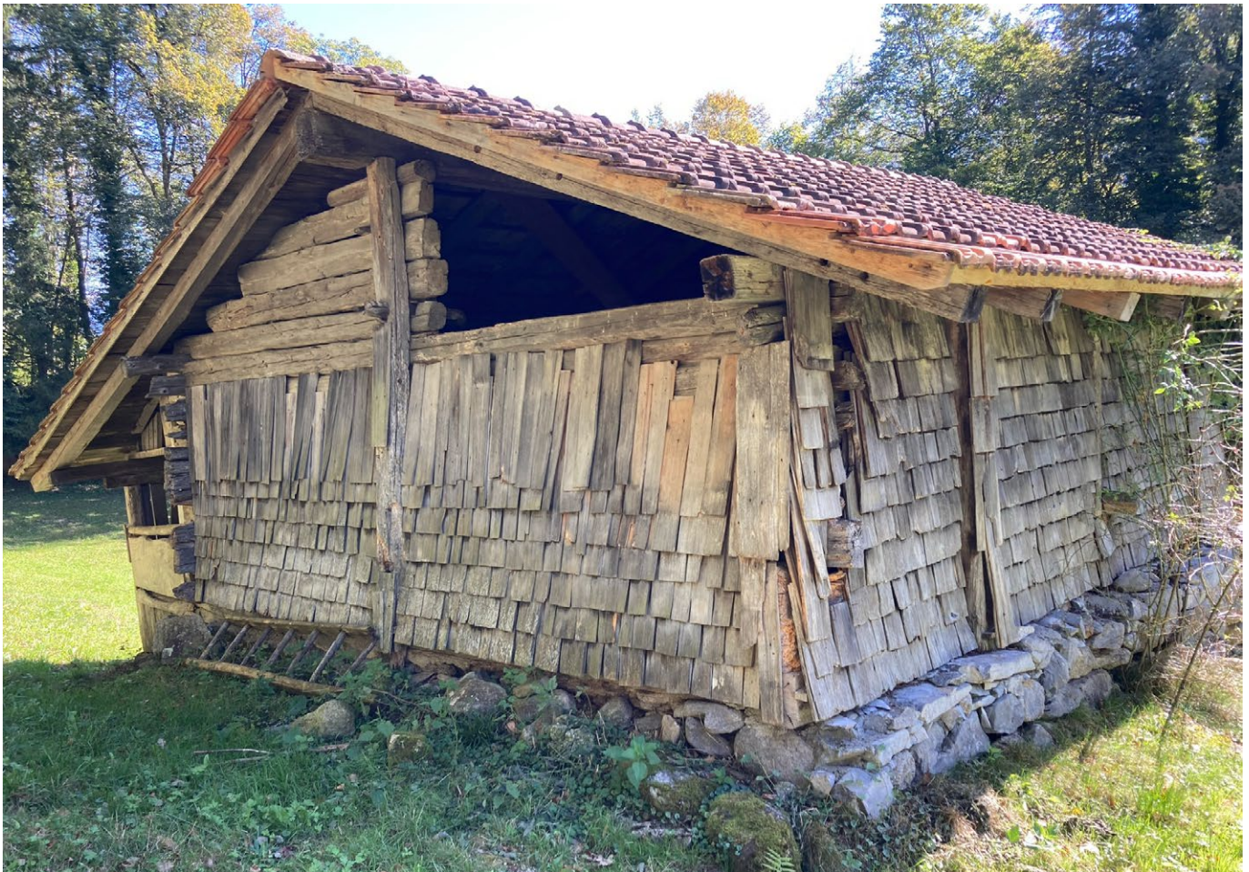
21 Freilichtmuseum der Schweiz, Heustall aus Brienzwiler: Um das Gebäude vor Schlagregen zu schützen, hat es eine zusätzliche Schindelschalung erhalten. Dabei wurden die Blockzangen überdeckt. Blick nach Osten. Aufnahme 2021.
