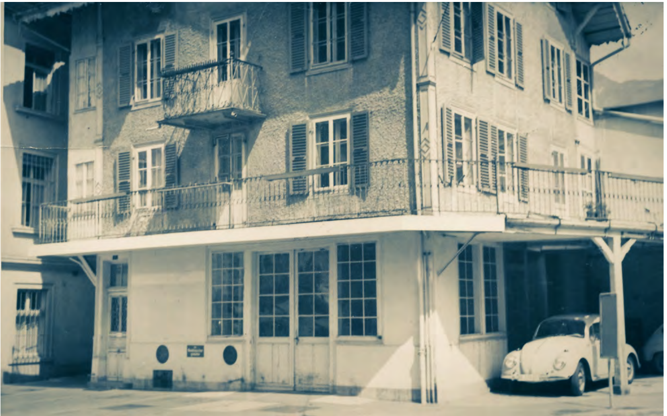
13 Interlaken, Schmiede am Centralplatz: Das Schmiedegebäude von Alfred Ritschard nach der Aufgabe der Werkstatt. Aufnahme 1968.
