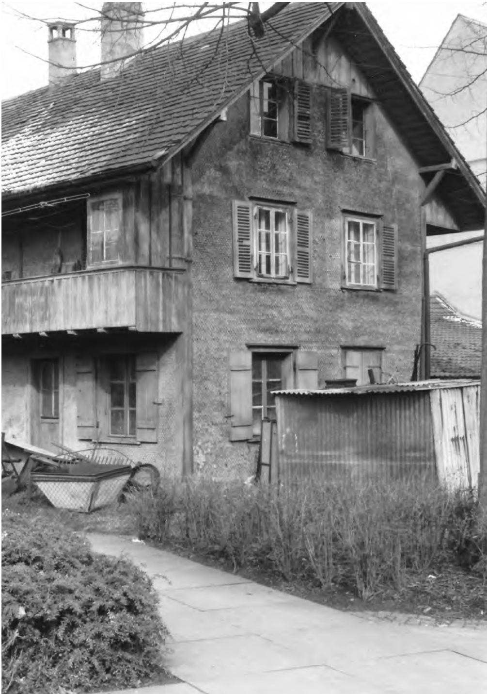
17 Bümppliz, Hufschmiede Bachmätteli: Südliche Rückansicht und westliche Trauffassade mit der Verschindelung und der bis zur Rückfassade durchlaufenden Laube im Obergeschoss. Blick vom westlich angrenzenden Stadtbach aus nach Nordosten. Aufnahme vor 1983.
