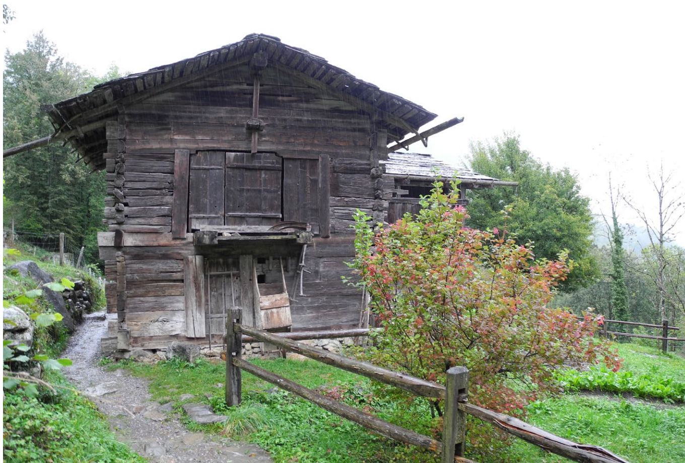
29 Freilichtmuseum der Schweiz, Heustall aus Blatten: West- und Haupteingangsseite in den Stall im Erdgeschoss und Heuraum im Obergeschoss. Die zuvor auf die schmale Plattform vor den Toren im Obergeschoss führende Leiter wurde im Freilichtmuseum nicht installiert. Der Stall wird heute nicht mehr für die Unterbringung von Nutztieren gebraucht. Aufnahme 2013.
