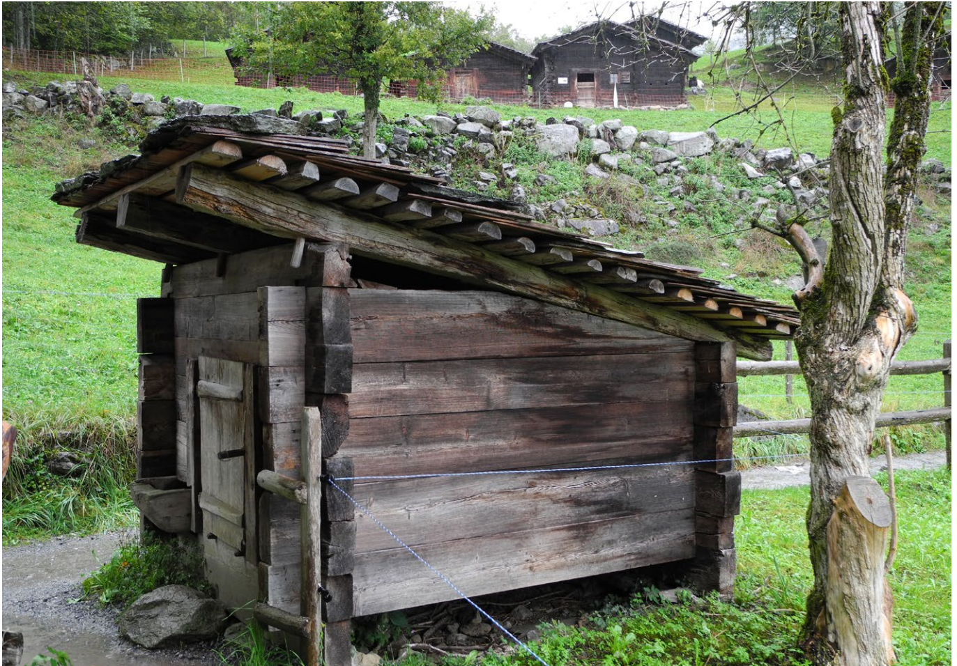
31 Freilichtmuseum der Schweiz, Schweineestall aus Blatten: Links der Tür die Einfüllöffnung des Futtertrogs im Schweineestall. Damit der Stall nicht betreten werden musste, ragte der Trog über die Fassadenflucht hinaus. Blick nach Südosten. Aufnahme 2013.
