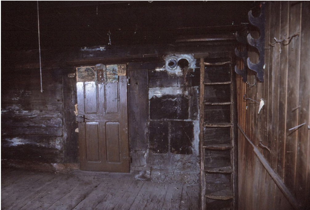
18 Blatten, Haus Ebener: Die Stube mit den eingemauerten Fragmenten des Giltsteinofens, darüber die Abzugsrohre der beiden, zuletzt in der Stube stehenden Öfen, sowie der Treppenaufgang in die Kammer im oberen Geschoss. Blick nach Norden. Aufnahme 1983.
