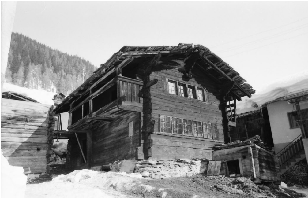
13 Blatten, Haus Ebener: Das Wohnhaus mit davorliegendem Schweinestall und Heustall auf der linken Bildseite. Aufnahme ca. 1985.
