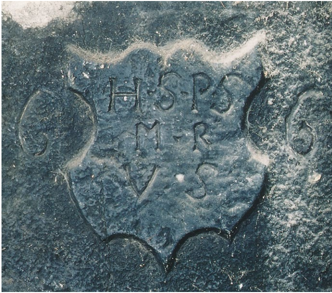
10 Blatten, Haus Ebener: Der Frontstein des Giltsteinofens, datiert 1663, war in die Wand zwischen Stube und Küche eingemauert. Aufnahme auf der Stubenseite. Blick Richtung Norden. Aufnahme 1983.
