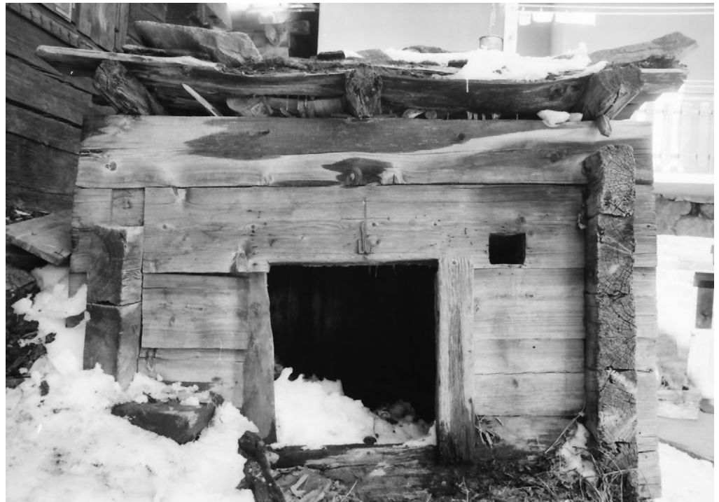
23 Blatten, Schweineestall Ebener: Westansicht des Schweineestalls ohne Türblatt. Links unten ist der Überstand des Schweinetrogs, welcher von ausssen eingefüllt wurde, in Ansätzen sichtbar. Aufnahme 1984.
