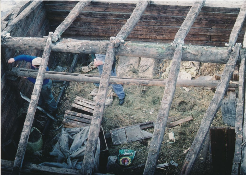
21 Blatten, Heustall Ebener: Einblick in den Heuraum bei der Demontage. Die Firstpfette mit den aufgelegten und fixierten Rafen ist sichtbar, die Dachhaut ist bereits entfernt. Aufnahme 1984.
