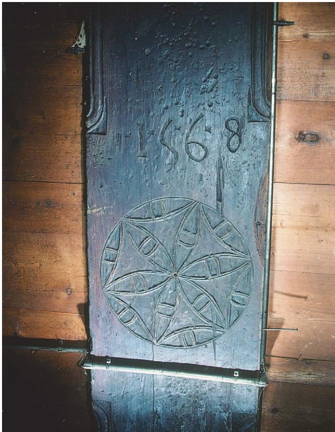
8 Blatten, Haus Ebener: di Binda – der quer zur Firstrichtung, West-Ost laufende Unterzug an der Stubendecke mit Baudatum 1568 und eingekerbter Rosette. Aufnahme 1983.
