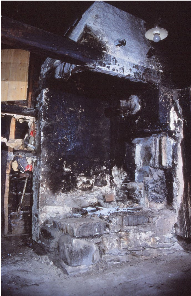
19 Blatten, Haus Ebener: Die offene Feuerstelle in der Südostecke der Küche. Auf dem flachen Natursteinsockel wurde das offene Feuer geschürt, im Rauchfang über der Feuerstelle Fleisch geräuchert. Aufnahme 1983.
