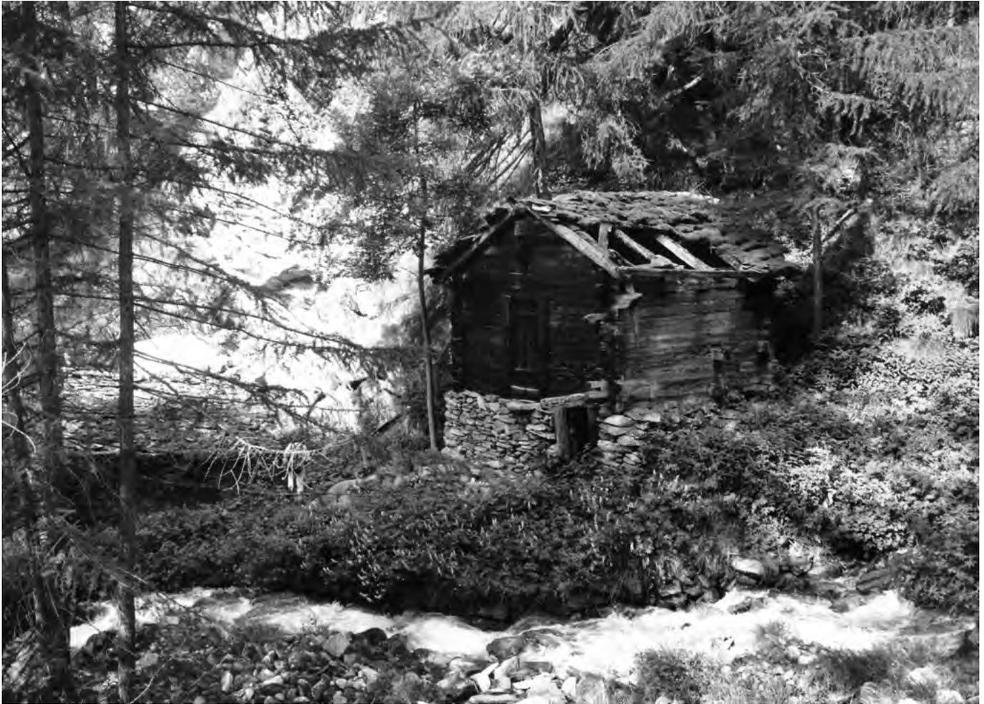
**7** Törbelbach: Die auf den Ballenberg translozierte Mühle war im Sockelgeschoss mit trockengemauerten Feldsteinen als Massivbau ausgeführt. Hier wurden Wasserräder und Wellbäume anhand des durchfließenden Wassers angetrieben. Im oberen, als Kantholzblockbau errichteten Geschoss, standen die beiden Mahlwerke. Aufnahme vor 1984.
