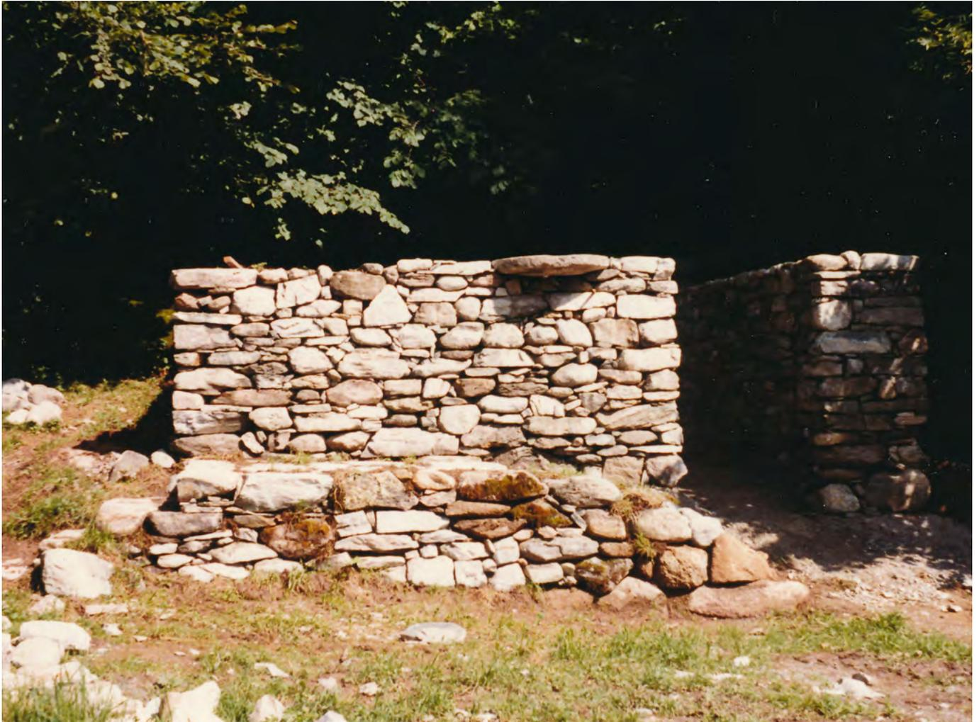
**11** Freilichtmuseum der Schweiz, Mühle aus Törbel: Der Wiederaufbau der Mühle auf dem Ballenberg erfolgte ab 1985. Das Sockelgeschoss des Museumsgebäudes wurde, wie es in Törbel auch der Fall war, in den Hang hineingebaut. Der ausgediente Mühlstein, der als Trittstufe in das Obergeschoss umgenutzt wurde, ist wieder an Ort und Stelle versetzt. Blick nach Nordwest. Aufnahme 1985.
