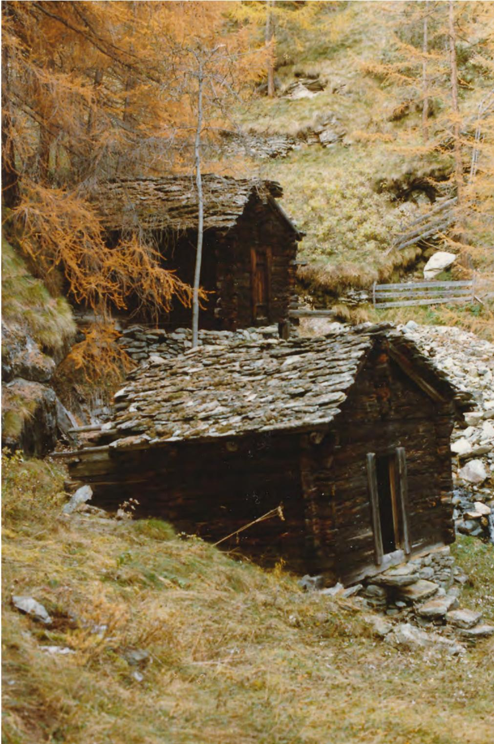
**5** Törbelbach: Die beiden obersten Törbler Mühlen standen in steilem und überschwemmungsgefährdetem Gelände. Die hintere wurde im Freilichtmuseum wiederaufgebaut, wobei Fragmente des vorderen Gebäudes, darunter ein Mühlstein und ein Wasserrad, als Ersatzmaterial verwendet wurden. Blick ungefähr nach Nordosten. Aufnahme 1982.
