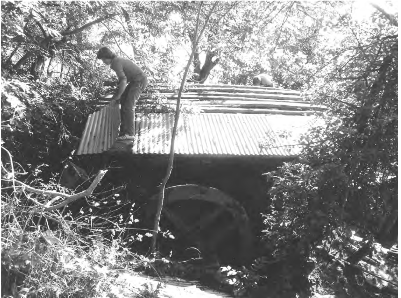
13 Naters, Mühle im Weiler Stockji: Während des Abbaus. Die Wellblechdeckung aus den 1960er Jahren wurde nicht übernommen. Zuvor war das Dach mit Lärchenschindeln gedeckt, die der Müller Marius Salzmann noch selbst gespalten hatte. Blick nach Osten. Aufnahme 1984.
