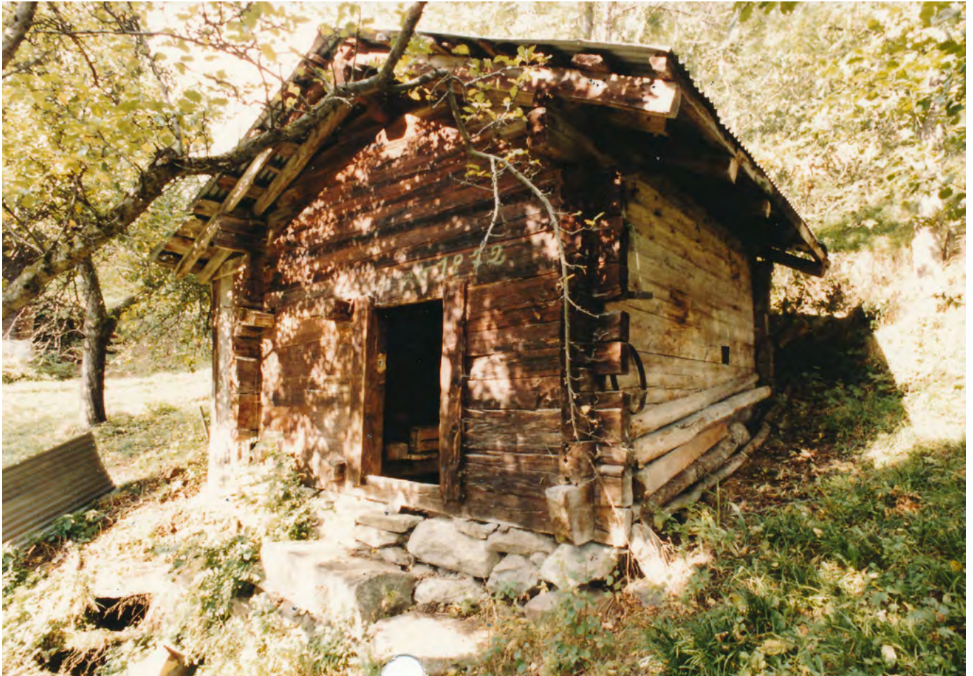
8 Naters, Mühle im Weiler Stockjki: Oberhalb des Türsturzes waren in Kurrentschrift zwei Monogramme eingekerbt, die auf die Erbauer der Mühle zurückgehen könnten. Möglicherweise handelte es sich dabei um die Grossväter des letzten Müllers, Marius Salzmann. Die Jahreszahl 1872 könnte auf eine Instandsetzungsmassnahme hindeuten. Aufnahme 1983.
