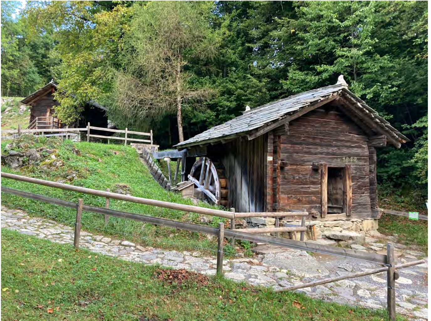
14 Freilichtmuseum der Schweiz, Mühle aus Naters: Die Mühle steht heute gemeinsam mit der Mühle aus Törbel in der Geländekammer Wallis. Die Gebäude zeigen zwei unterschiedliche Formen des Wasserantriebs. Blick nach Norden. Aufnahme 2022.
