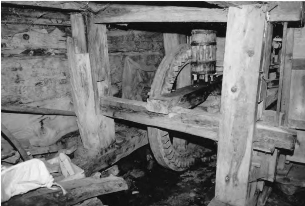
10 Naters, Mühle im Weiler Stockji: Blick auf das Kammrad und das Laternenrad. Hier fand die Übersetzung von der vertikalen zur horizontalen Bewegung statt, die den oberen Mühlstein, den Läuferstein, in die Drehung versetzte. Aufnahme undatiert.
