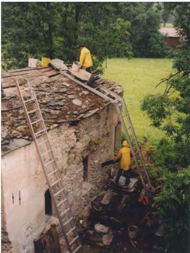
**17** Turtig, Agathakapelle: Der Start der Abbrucharbeiten am 26. Juni 2000. Zunächst wurden die schweren Steinplatten der Dachdeckung abgehoben. Zum Teil waren die Steine nicht mehr wiederzuverwenden. Blick nach Nordwesten. Aufnahme 2000.
