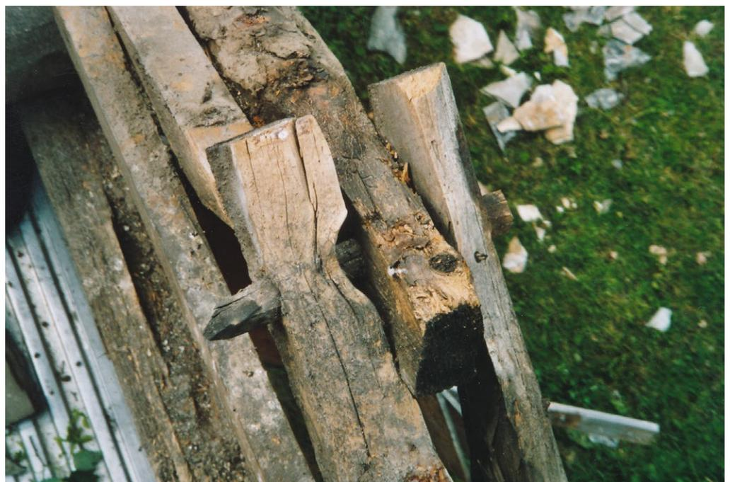
**14** Vals, Ortsteil Camp: Mittels Firstscherzapfen waren die Rafen am Scheitelpunkt des Dachs miteinander verbunden. Diese Holzverbindung ermöglicht Druckbewegungen in verschiedene Richtungen. Aufnahme 2009.
