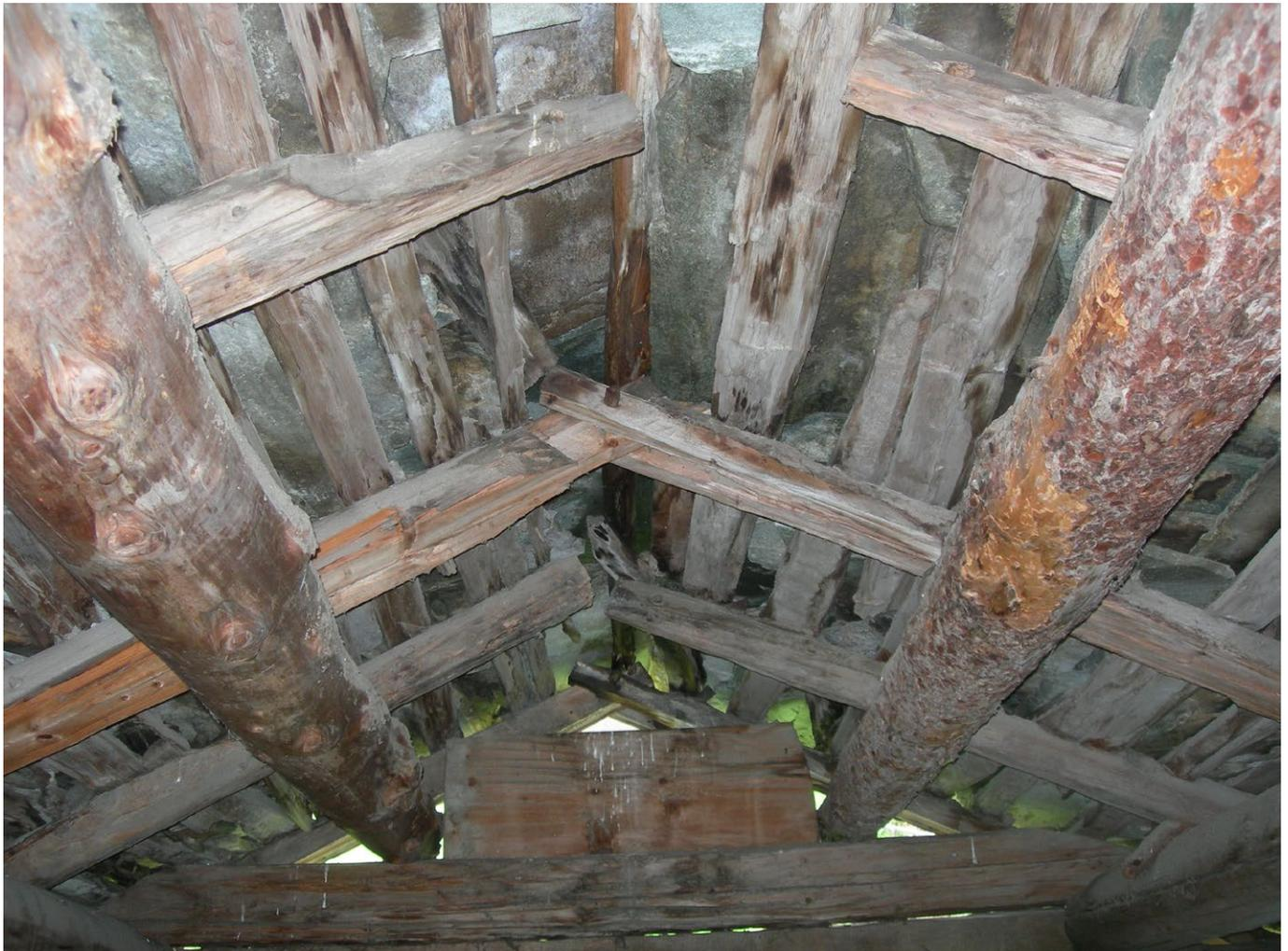
**13** Vals, Ortsteil Camp: Um die Schnee- und Steinlast tragen zu können, waren die Pfetten gross dimensioniert. Teilweise bestanden sie aus unbearbeiteten Baumstämmen, denen lediglich die Äste abgeschlagen wurden. Aufnahme 2009.
