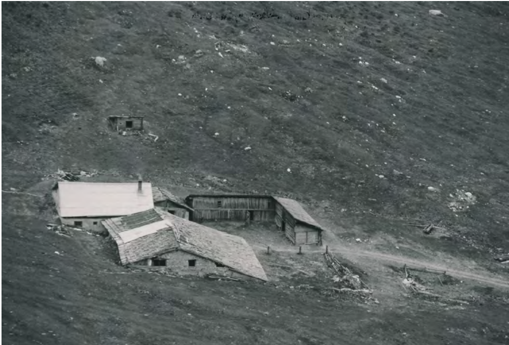
7 Val Müstair, Alp Champatsch: Die Alpgebäude vor ihrem Abbau. Der winkelförmige Stall wurde nicht auf den Ballenberg übernommen. Rechts neben dem Schermen stand früher ein weiterer, rechteckiger Unterstand. Blick nach Süden. Aufnahme 1987.
