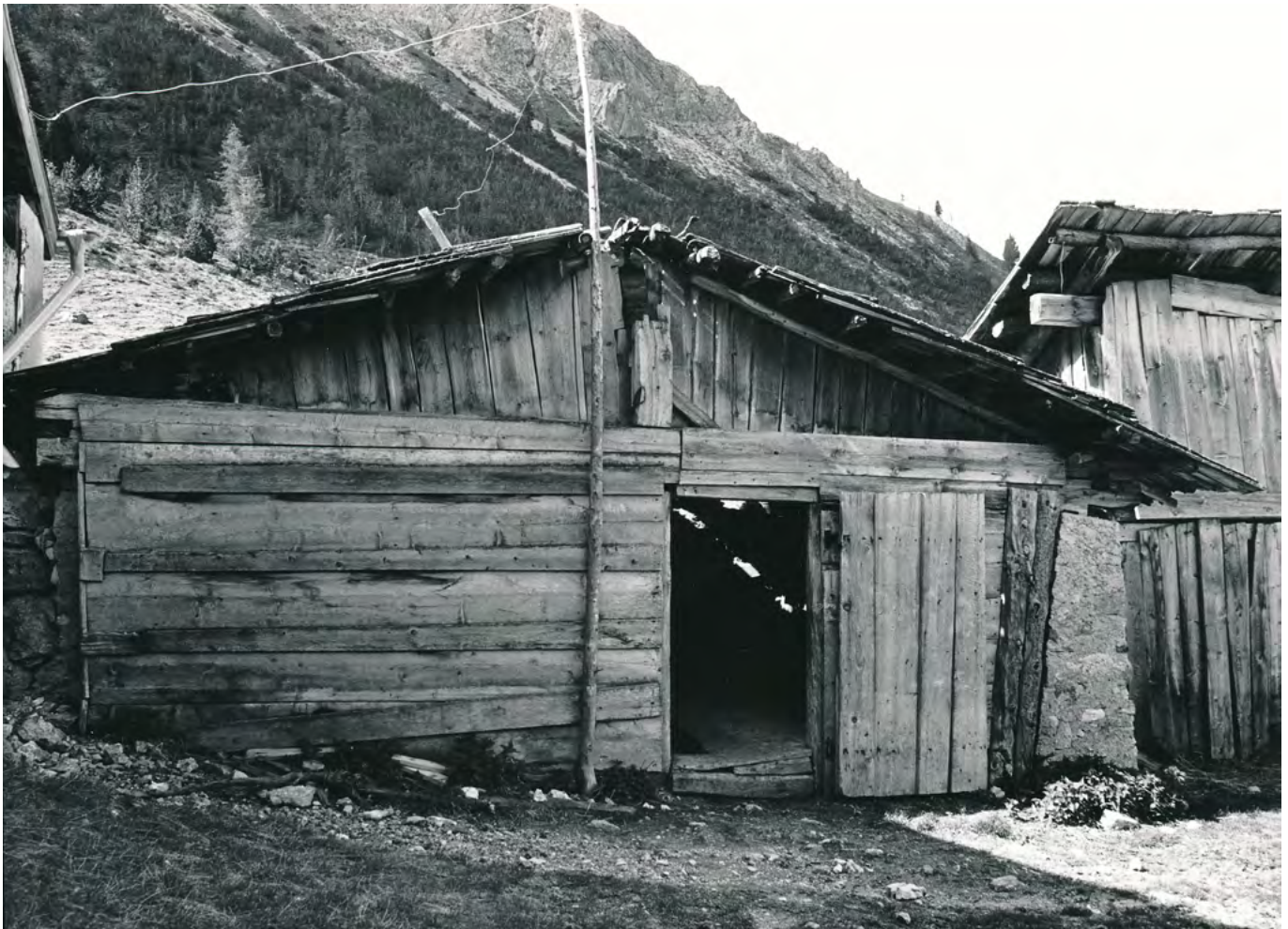
19 Val Müstair, Alp Champatsch: Die Nordfassade des Alpstalls. Der Eingang ist nach Westen verschoben, da sich in der Mitte der Firstständer befindet. Blick nach Süden. Aufnahme 1987.
