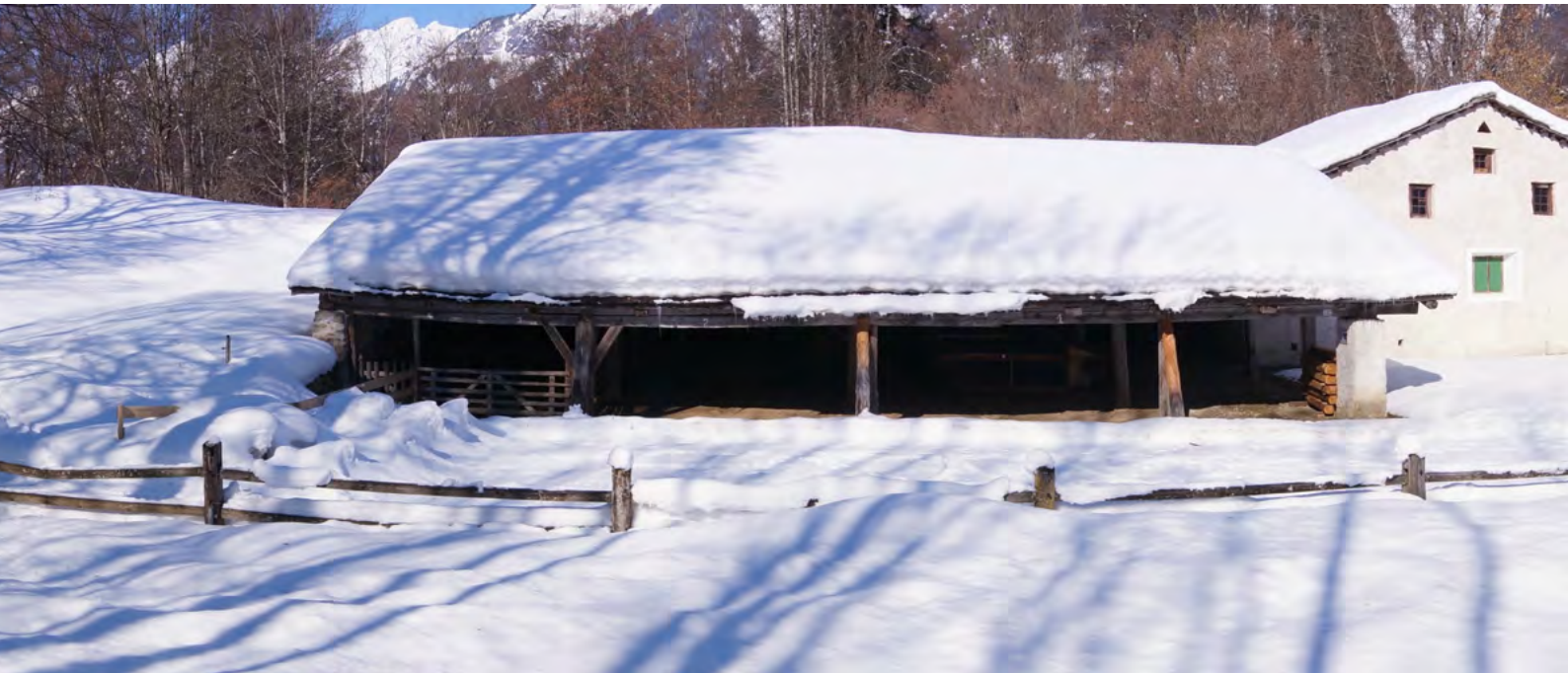
26 Freilichtmuseum der Schweiz, Alpgebäude Alp Champatsch: Die Anordnung der Gebäude im Freilichtmuseum orientierte sich am Originalstandort. Der Schermen wurde auf seine Grösse vor der Erweiterung um 1950 zurückgeführt und ist und nun wieder an einer Trauf- und Giebelseite offen. Der Schweinestall steht auch hier vom Gebäudekomplex abgerückt. Blick nach Nordwesten. Aufnahme 2013.
