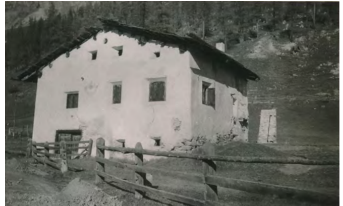
24 Val Müstair, Lü: Einige Gebäude in Lü weisen starke Ähnlichkeiten mit der Sennhütte der Alp Champatsch auf, bei diesem Gebäude sind es Anordnung und Form der Öffnungen in der Schaufassade sowie die die Giebelfläche durchstossenden Pfetten. Aufnahmedatum unbekannt.
