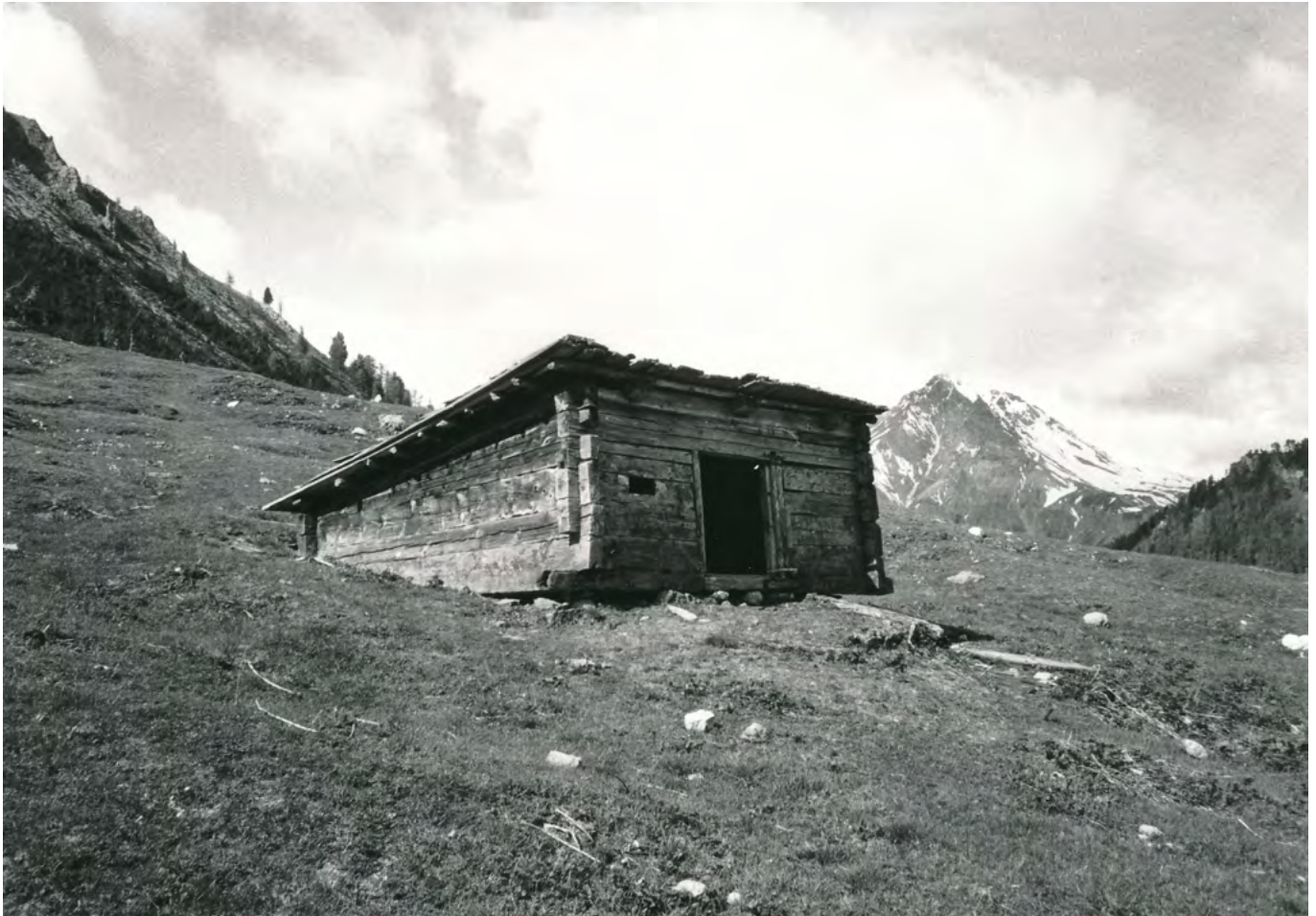
21 Val Müstair, Alp Champatsch: Der Schweinestall stand abseits der Hofanlage, wie es südlich der Alpen typisch war. Es handelte sich um einen einfachen, aber raffinierten Blockbau. Um die Neigung des Pultdaches herzustellen, wurden die Hölzer der Ost- und Westfassade konisch zugerichtet. Blick nach Südwesten. Aufnahme 1987.
