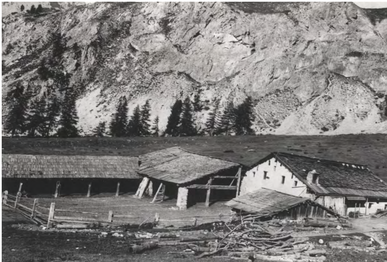
4 Val Müstair, Alp Champatsch: Diese älteste bekannte Aufnahme aus dem frühen 20. Jahrhundert zeigt den Schermen noch ohne westliche Verlängerung, dafür mit dem angrenzenden längsrechteckigen Stall, welcher später abgebrochen wurde. Blick nach Nordwesten. Aufnahme vor 1922.
