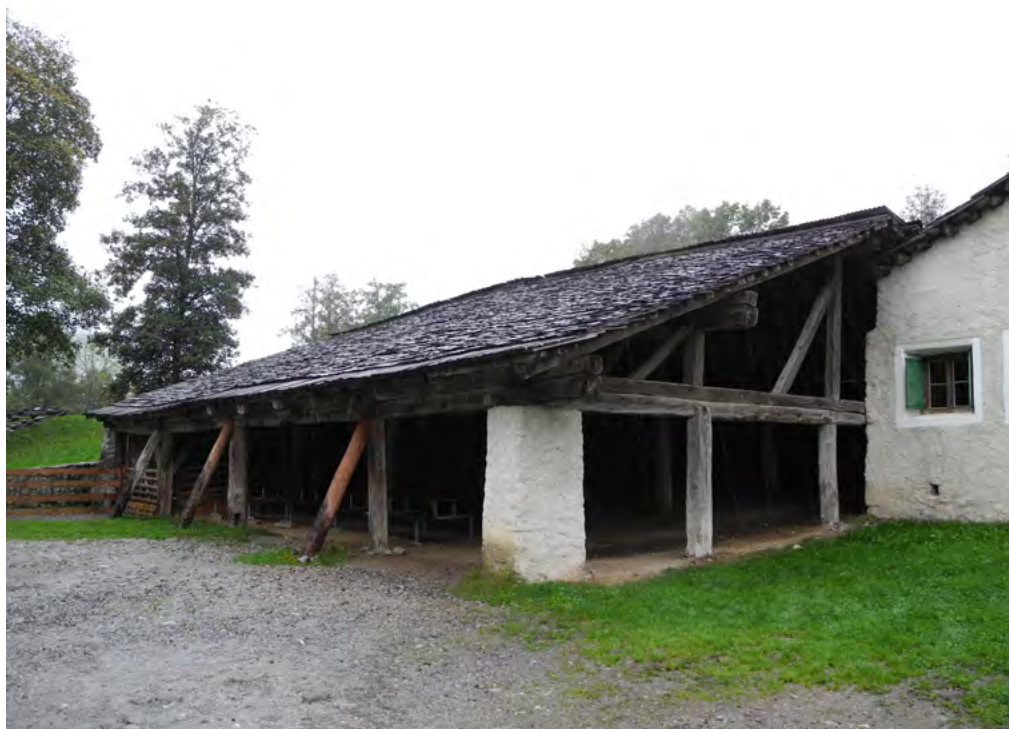
32 Freilichtmuseum der Schweiz, Alpbgebäude Alp Champatsch: Der auf der Aufnahme um 1920 von Eugenie Goldstern erkennbare gemauerte Eckpfeiler am Schermen wurde im Freilichtmuseum rekonstruiert. Blick nach Westen. Aufnahme 2013.
