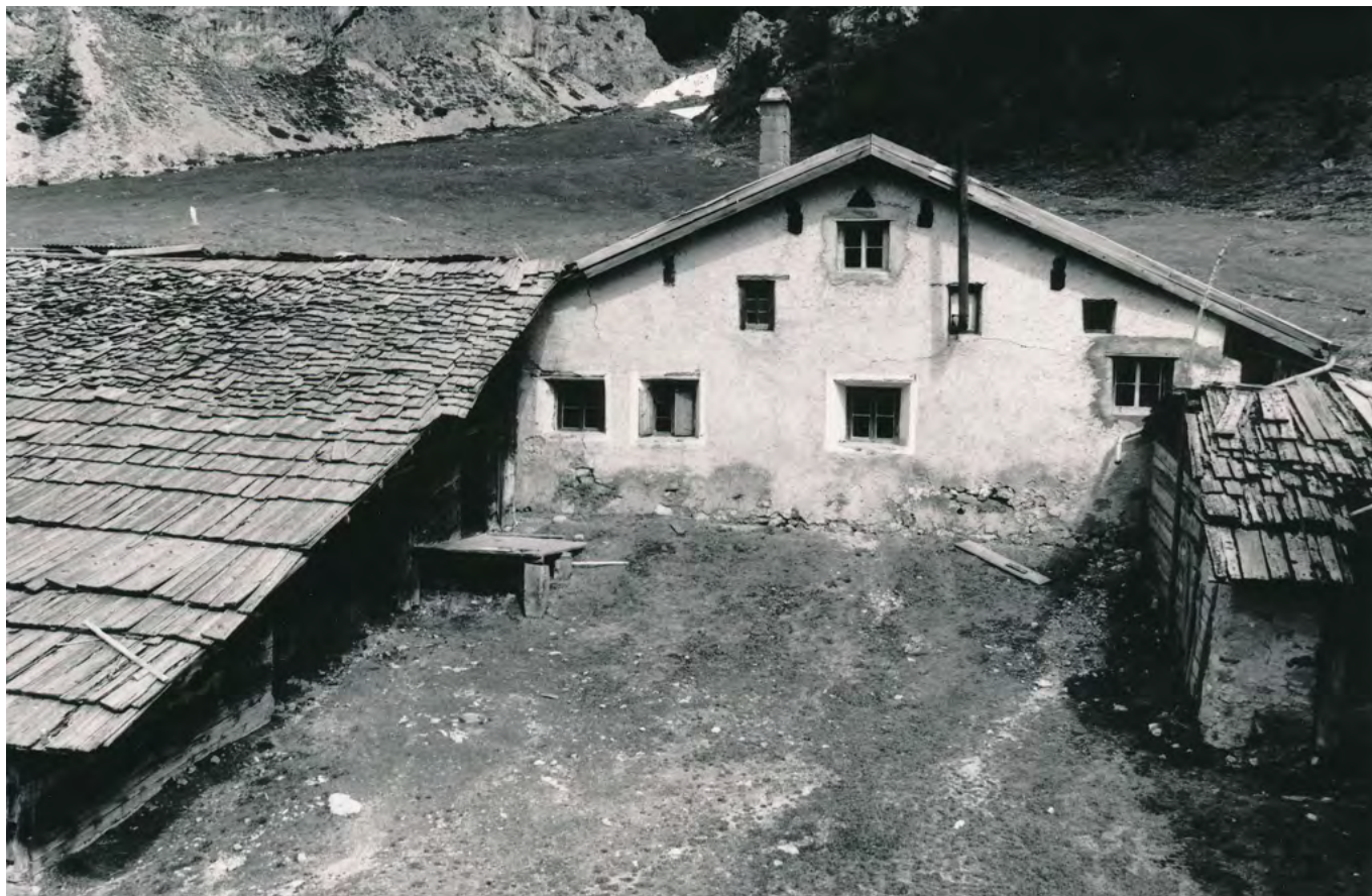
12 Val Müstair, Alp Champatsch: Die Westfassade der Sennhütte. Im Zuge verschiedener Umbaumaassnahmen kamen neue Fensteröffnungen hinzu oder wurden erweitert. Vermutlich waren die Fenster ursprünglich symmetrisch angeordnet. Blick nach Osten. Aufnahmedatum unbekannt.
