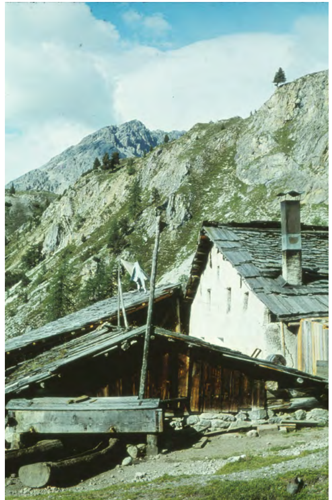
8 Val Müstair, Alp Champatsch: Schermen (Hintergrund), Sennhütte (rechts) und Alpstall (Vordergrund) bildeten einen dreiseitigen Hof. Blick nach Norden. Aufnahme 1987.
