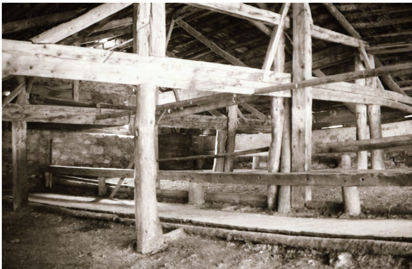
9 Val Müstair, Alp Champatsch: In den 1950ern wurde der Schermen mit Lägern und Barmenbalken ausgestattet. Bis dahin konnten sich die Tiere im Schermen frei bewegen. Blick nach Nordwesten. Aufnahme vermutlich 1989.
