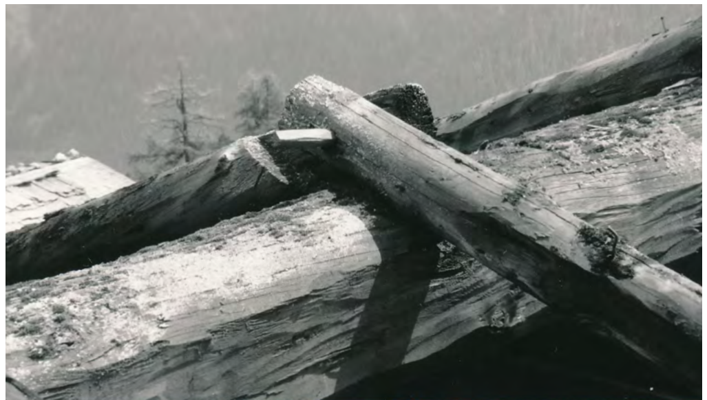
25 Bellwald, Alp Richinen: Rafenpaarverbindung über der Firstpfette des Alpstalls mit Schweinestall, Nr. 1342. Aufnahme von 1984.
