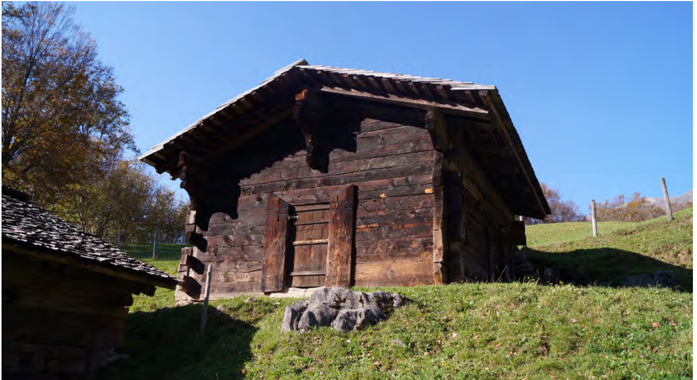
43 Freilichtmuseum der Schweiz, Sennhütte und späterer Alpstall, Nr. 1343: Das Gebäude hat keine Einrichtung erhalten und ist für Gäste nicht zugänglich. Blick nach Nordwesten. Aufnahme 2013.
