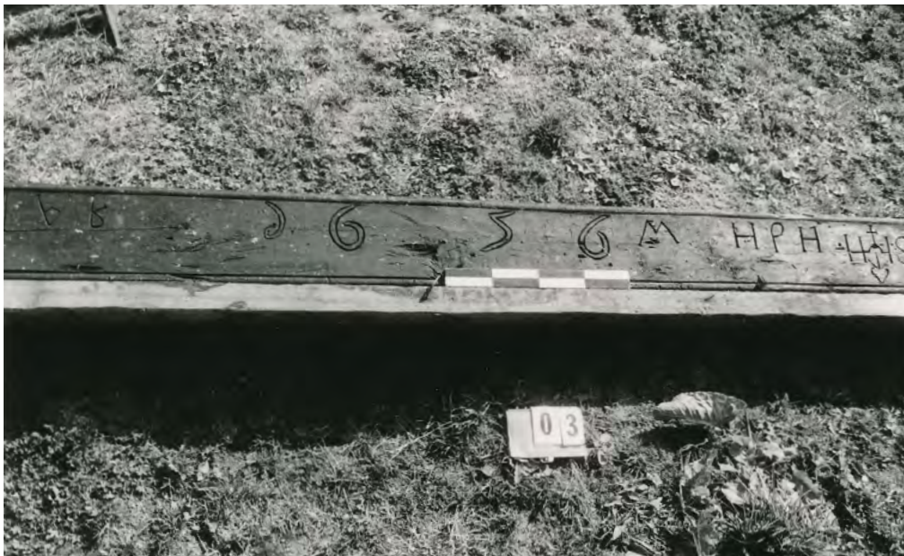
10 Bellwald, Alp Richinen: Den Deckenbalken der Sennhütte/Alpstall, Nr. 1343, zierten die Jahreszahl 1656, Initialen und ein Jesus-Monogramm. Aufnahme während des Abbaus 1984.
