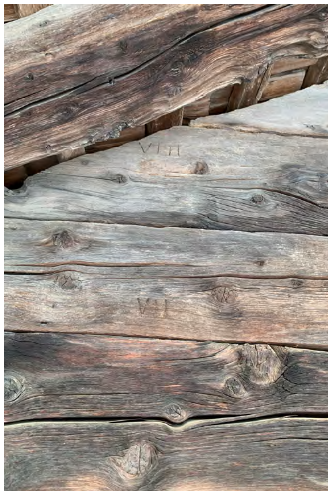
11 Freilichtmuseum der Schweiz, Sennhütte/Käselager, Nr. 1345: Die Abbundzeichen deuten auf eine frühere Translozierung des Gebäudes hin. Aufnahme 2021.
