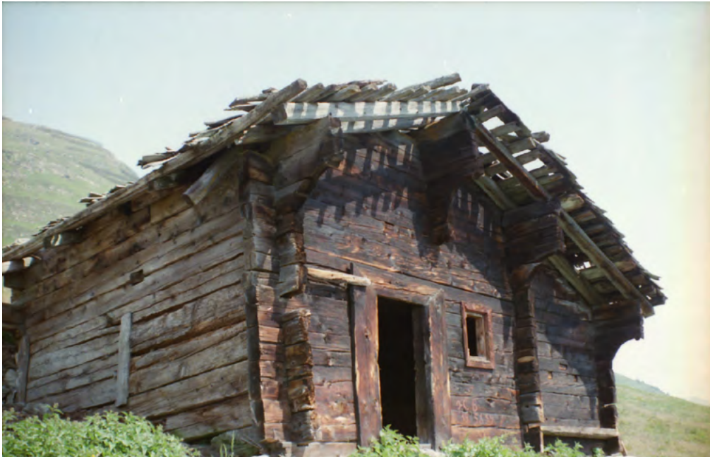
14 Bellwald, Alp Richinen: Ansicht der Sennhütte, Nr. 1341, von Süden. Die Dachdeckung ist bereits abgängig und das Gebäude längst nicht mehr in Gebrauch. Blick nach Norden. Aufnahme vor 1985.
