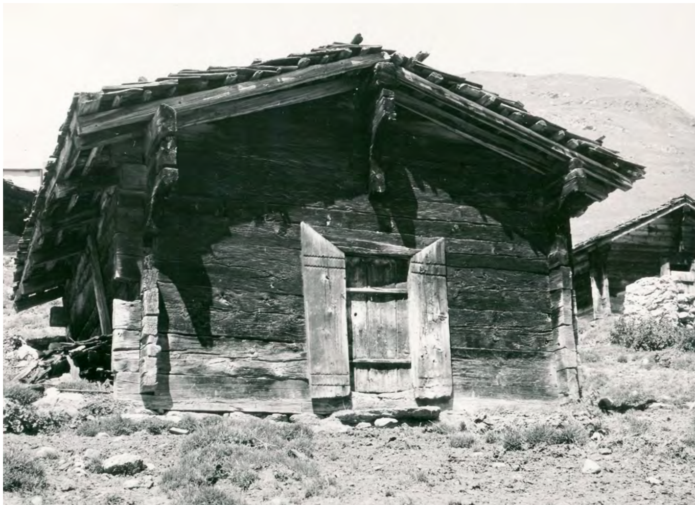
28 Bellwald, Alp Richinen: Südfassade der Sennhütte/Alpstall, Nr. 1343. Dieses Gebäude wurde mit der Umnutzung zum Alpstall verkleinert und der östlich angebaute Raum abgetragen. Blick nach Norden. Aufnahmezeitpunkt unbekannt.
