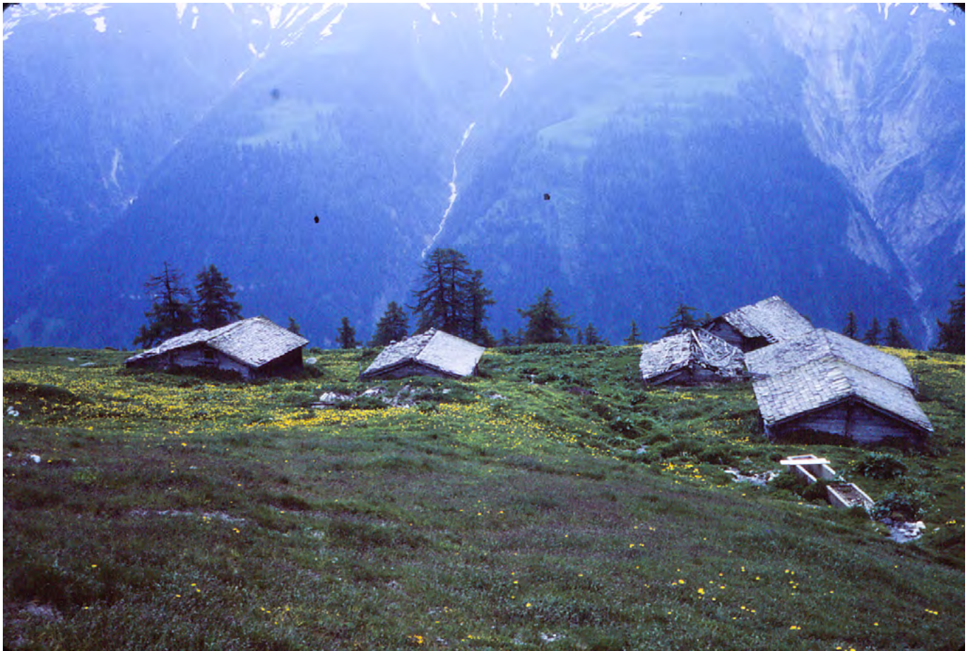
12 Bellwald, Alp Richinen: Fast alle Gebäude auf Richinen verfügten über ein flaches Satteldach, welches mit Spaltschindeln gedeckt war. Blick nach Südsüdosten. Aufnahme von 1983.
