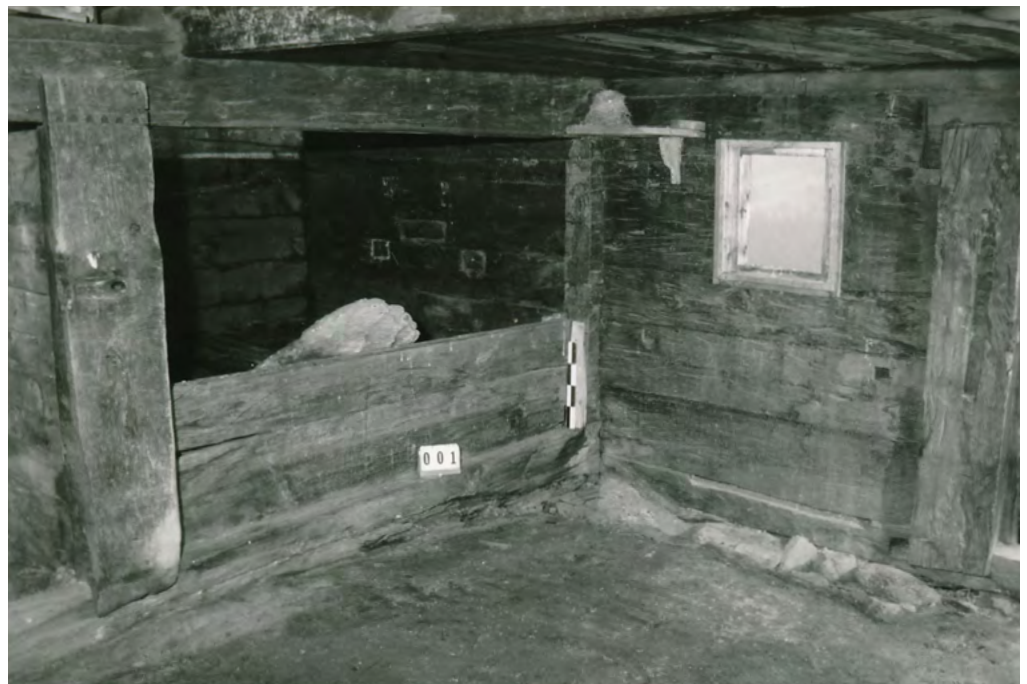
19 Bellwald, Alp Richinen: Innenraum der Sennhütte, Nr. 1341, mit Schlafpritsche und den sogenannten Fuchslöchern an der Südostwand. Aufnahme vor 1985.
