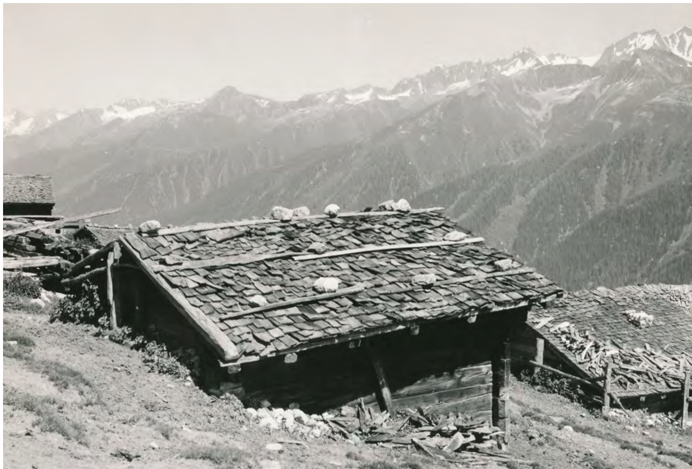
13 Bellwald, Alp Richinen: Die Spaltschindeln einiger Dächer waren zusätzlich mit Schwarsteinen und -hölzern beschwert, um die Schindeln an Ort und Stelle zu halten. Diese Technik stammt aus der Zeit vor der industriellen Fertigung von Nägeln. Blick nach Südosten. Aufnahmezeitpunkt unbekannt.
