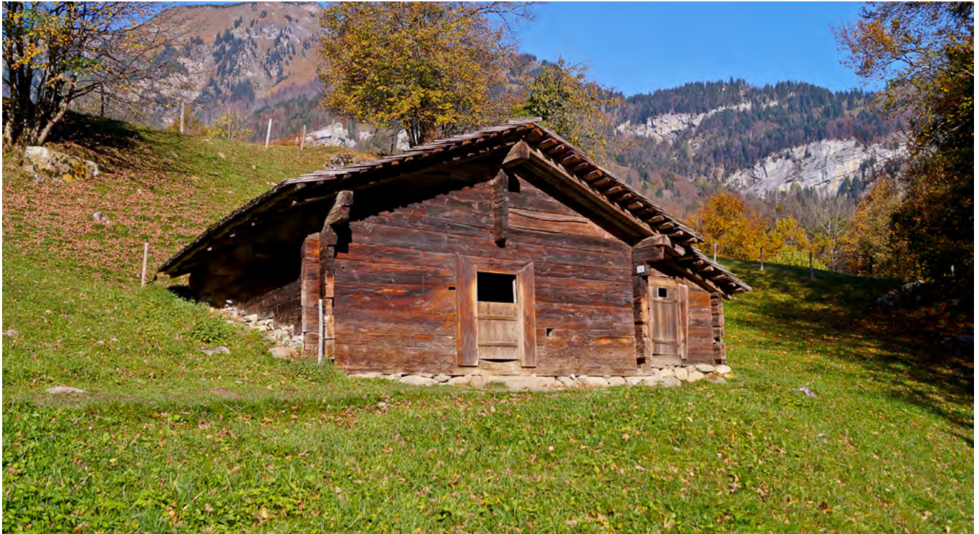
42 Freilichtmuseum der Schweiz, Alpstall mit Schweineestall, Nr. 1342: Der Stall wird heute nicht mehr zur Viehhaltung genutzt. Blick nach Nordosten. Aufnahme 2013.
