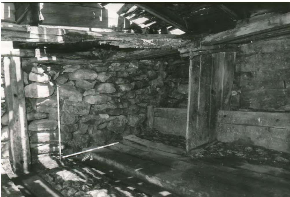
27 Bellwald, Alp Richinen: Die Stalleinrichtung des Alpstalls, Nr. 1342. Die Unnerschlachten sorgten dafür, dass das Vieh nach Besitzern getrennt im Stall stehen konnte. Aufnahme vor 1985.
