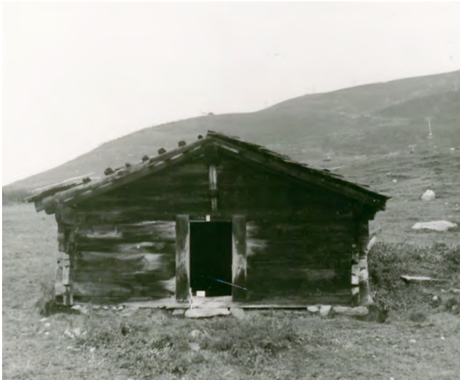
33 Bellwald, Alp Richinen: Südostfassade des Alpstalls, Nr. 1344. Blick nach Nordwesten. Aufnahme vor 1985.
