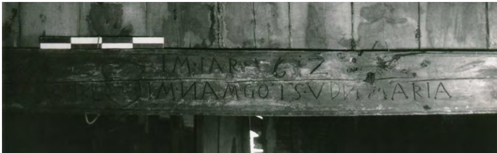
9 Bellwald, Alp Richinen: Der Deckenbalken in der Sennhütte, heute Nr. 1341, war auffallend aufwendig gestaltet und mit Wappen, Initialen, einem Segensspruch und der Jahreszahl 1612 versehen. Aufnahme vor 1985.
