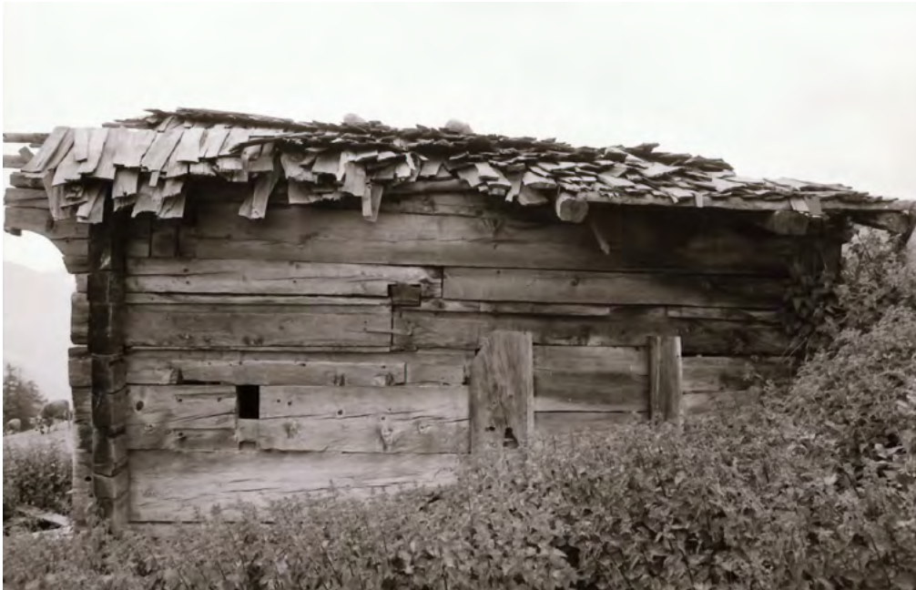
29 Bellwald, Alp Richinen: Die Ostwand der Sennhütte/Alpstall, Nr. 1343, bildete ursprünglich die Binnenwand zwischen Haupt- und Nebenraum. Der frühere Durchgang wurde mit horizontalen Brettern verschlossen, die Mantelstübe blieben stehen. Blick nach Südwesten. Aufnahme vor 1985.
