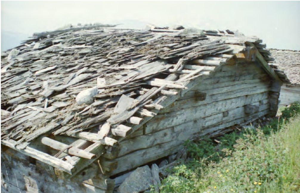
17 Bellwald, Alp Richinen: Das Dach der Sennhütte, Nr. 1341, war mit Spaltschindeln und Schwarsteinen gedeckt. Blick nach Süden. Aufnahme vor 1985.
