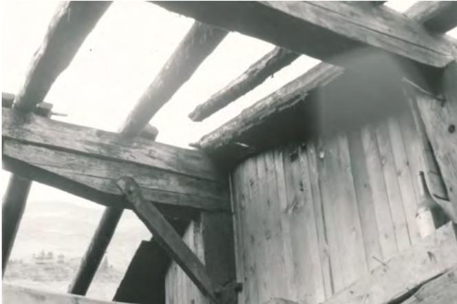
**10** Untere Allmenalp: Um die hohen Schneelasten im Winter tragen zu können, wurde die Firstpfette zusätzlich von einem Firstständer mit Sattelholz gestützt. Der Dachraum über den talseitig aneinandergereihten Räumen im Erdgeschoss wurde durch einfache Bretterwände zu einer Schlafkammer umfunktioniert. Blick nach Nordosten. Aufnahme um 1982.
