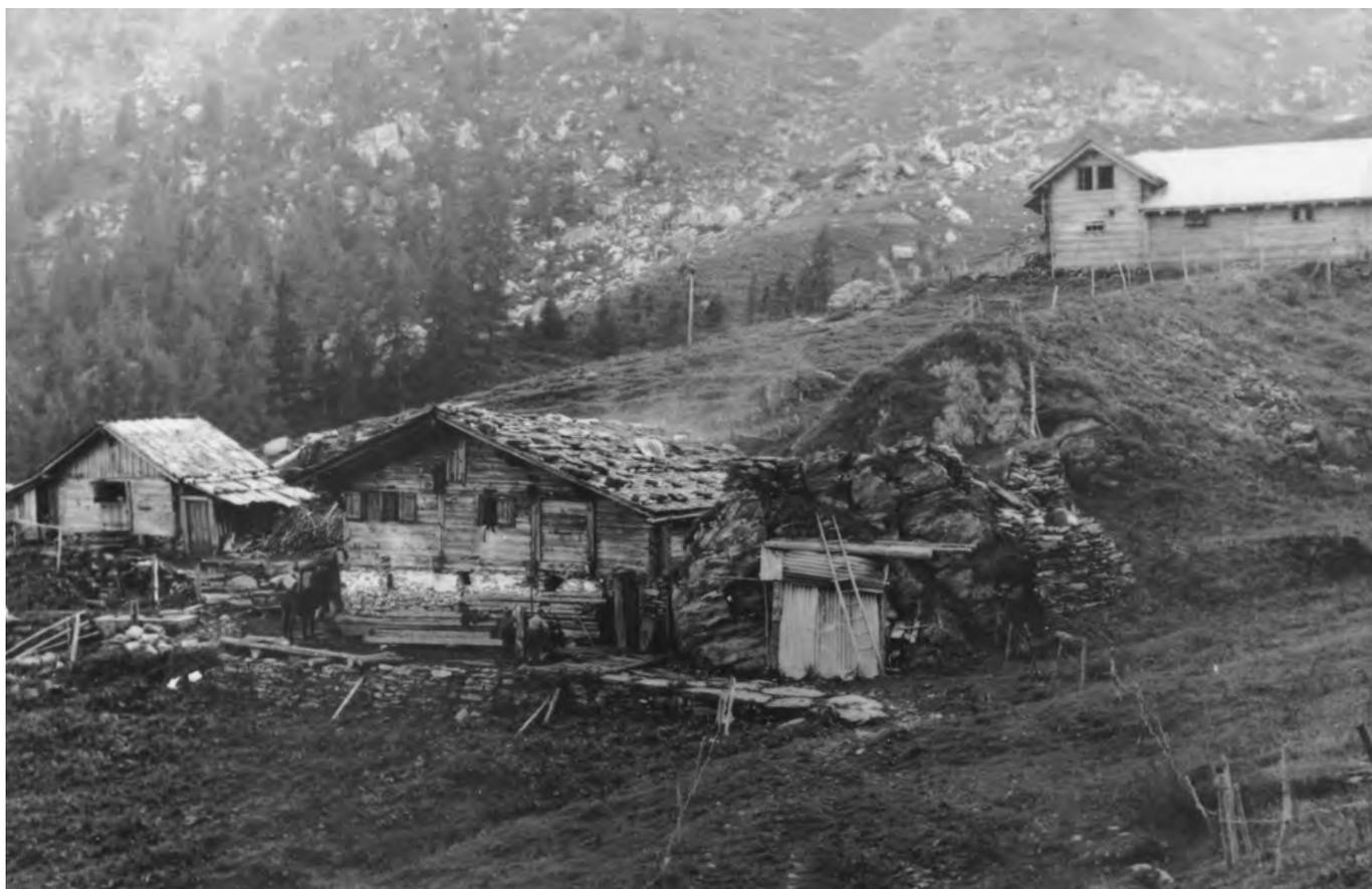
9 Untere Allmenalp: Die Sennhütte wurde zum Schutz vor Lawinen nah an einem Felsen errichtet. Mit der Zeit wurde dieser Alpstafel um zusätzliche Gebäude erweitert. Der grosse Stall im Hintergrund ist in Luftaufnahmen ab den 1940er Jahren fassbar. Das Dach der Sennhütte hat hier noch die alte Deckung aus Legschindeln, welche durch Schwarzhölzer und -steine beschwert und an Ort und Stelle gehalten wurden. Noch fehlen die Stützpfiler am Sockelgeschoss. Blick nach Süden. Aufnahme undatiert.
