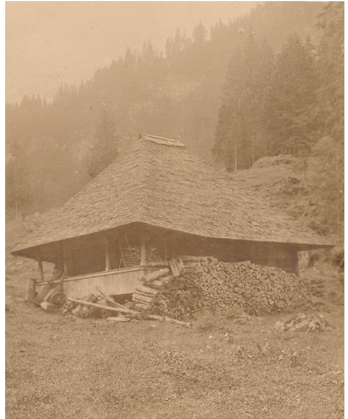
14 Kiental BE, Spiggengrund: Vergleichsbau. Auch südlich vom Thunersee im Kiental wurden Käsespeicher mit Walmdach errichtet. Aufnahme vermutlich um 1930.
