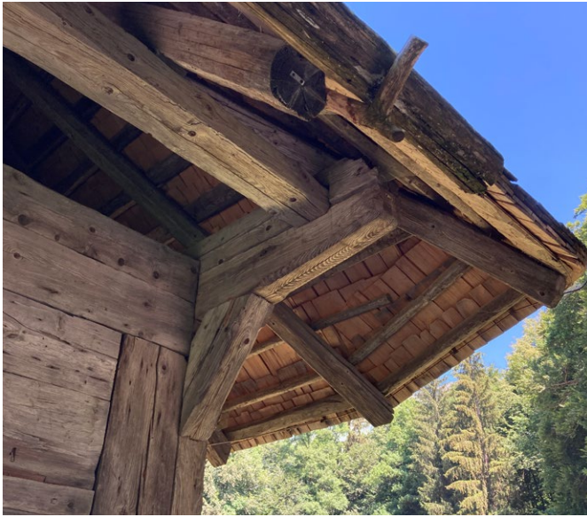
12 Freilichtmuseum der Schweiz, Käsespeicher aus Leissigen: Ein Blick in die Konstruktion des Walmdaches. Die Rafen des Vordaches werden von einer Flugpfette gehalten. Diese ist wiederum in die traufseitig vorstossenden Rähme gesteckt. Flugpfette und Büge sind zurückhaltend profiliert. Blick nach Norden. Aufnahme 2022.
