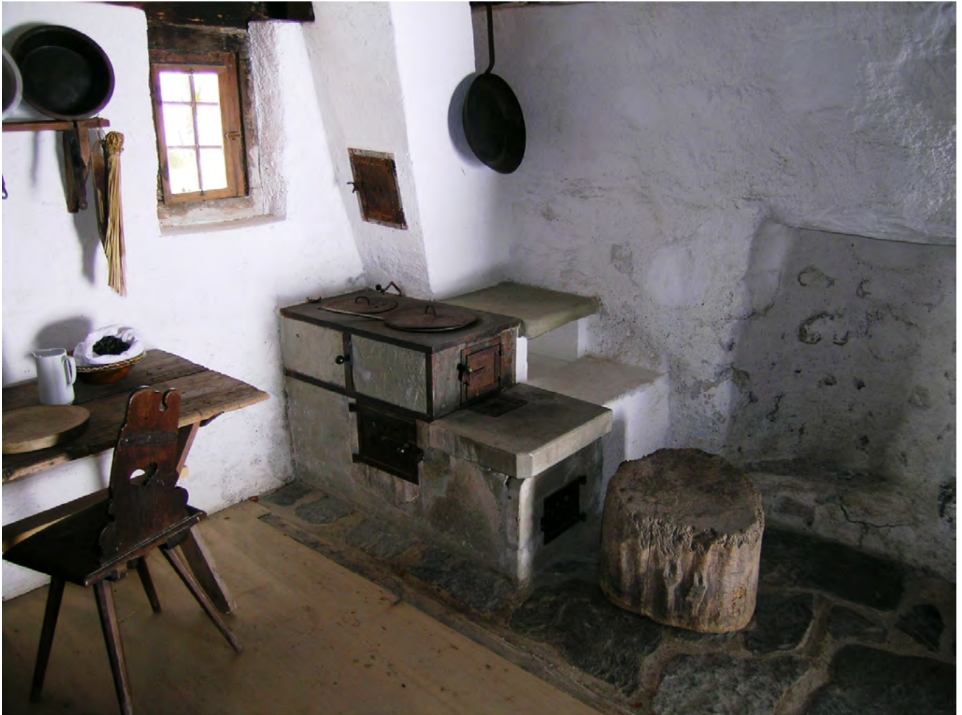
23 Freilichtmuseum der Schweiz, «Maiensässwohnhaus» aus Buochs: Auch der Kunstherd aus dem 19. Jahrhundert wurde wiederaufgebaut. Im Bereich der Kochstellen hat der Boden einen Belag aus Steinplatten erhalten. Blick nach Nordwesten. Aufnahme 2010.
