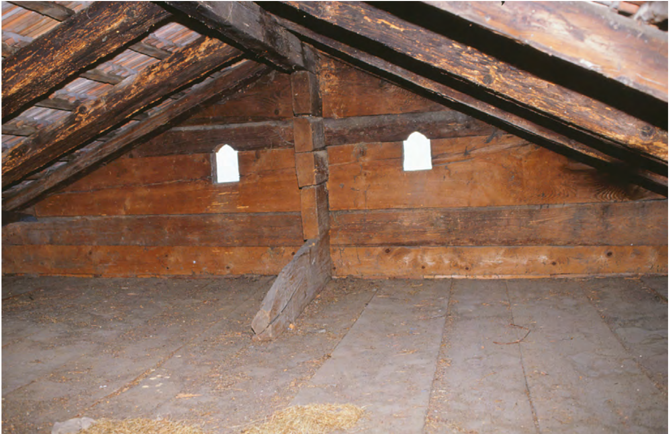
10 Buochs, Unter Feld: Dachraum, Blick nach Norden. Die Zierausschnitte ermöglichten eine Belüftung des niedrigen Raumes und begünstigten den Rauchabzug aus der offenen Feuerstelle in der Küche. Blick nach Nordosten. Aufnahme 2000.
