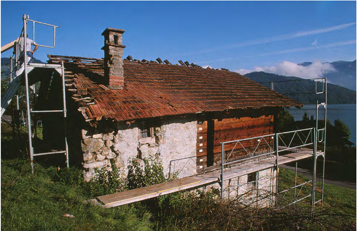
8 Buochs, Unter Feld: Das «Maiensässwohnhaus», Ostfassade. Im rückwärtig gelegenen gemauerten Teil des Erdgeschosses befand sich die Küche, die als Blockbau konstruierte Stube lag talseitig über dem Käsekeller und offerierte einen schönen Ausblick auf den Vierwaldstättersee. Blick nach Nordwesten. Aufnahme während des Abbaus 2000.
