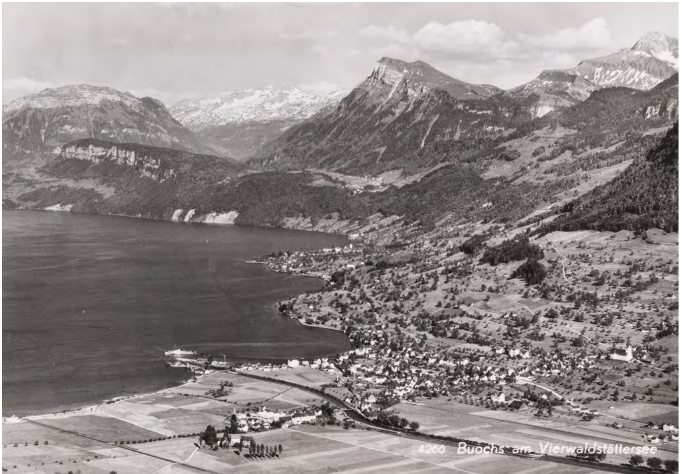
4 Buochs: Gut zu erkennen ist der historische Dorfteil, welcher sich in Falllinie mit den Ausläufern des Buochserhorns befindet. Das Schwemmland im Bildvordergrund konnte mittels Gewässerkorrekturen im 19. Jahrhundert in landwirtschaftliche Nutzflächen umgewandelt werden. Heute ist dieser Bereich dicht besiedelt. Blick nach Westen. Aufnahme 1947/48.
