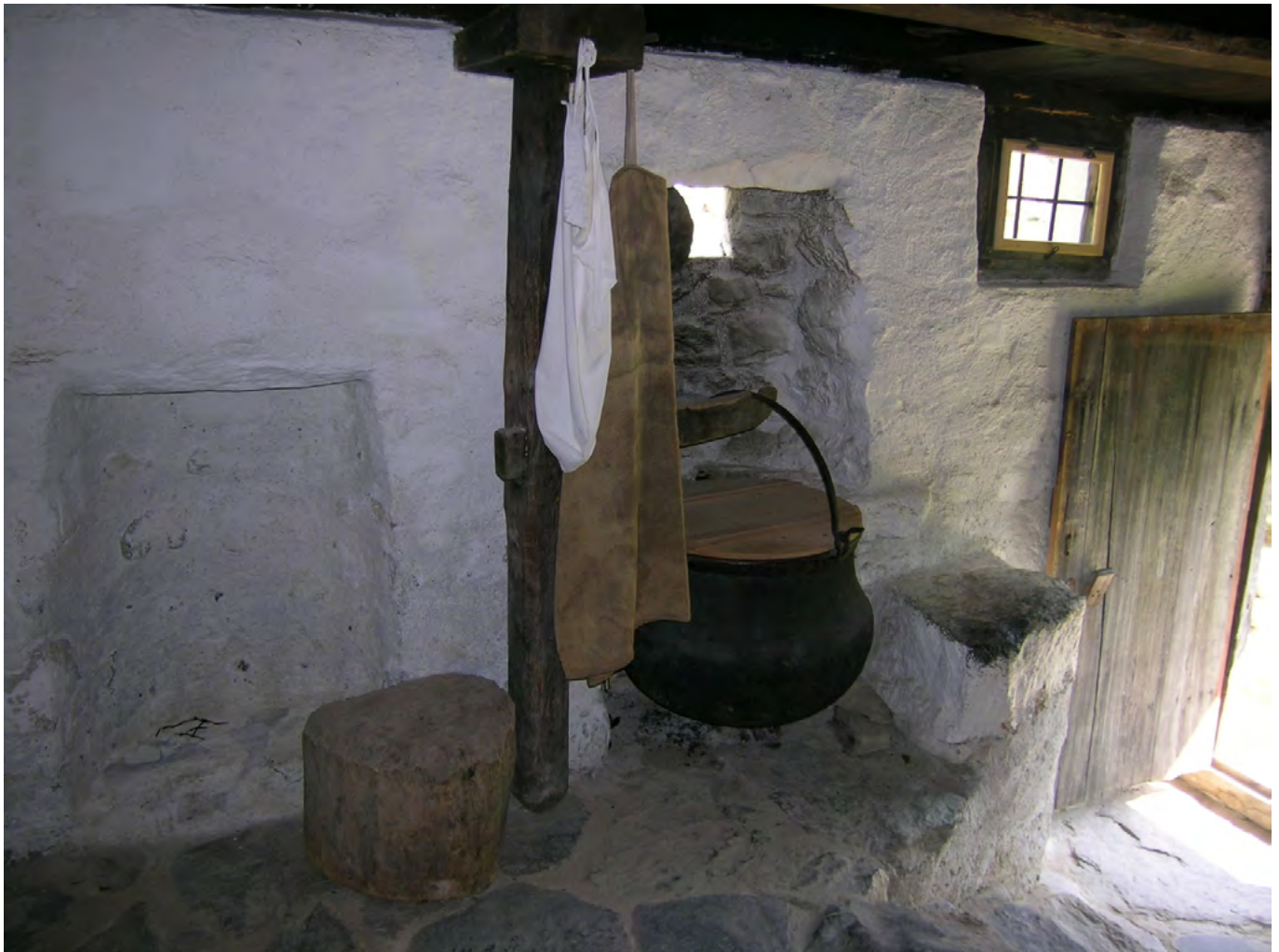
22 Freilichtmuseum der Schweiz, «Maiensässwohnhaus» aus Buochs: Die offene Feuerstelle wurde entsprechend ihrem früheren Funktionsprinzip mit Turner und Feuernische wiederaufgebaut. In die linke Ausbuchtung konnte der Käsekessel am Turner platzsparend eingeschwenkt werden. Blick nach Norden. Aufnahme 2009.
