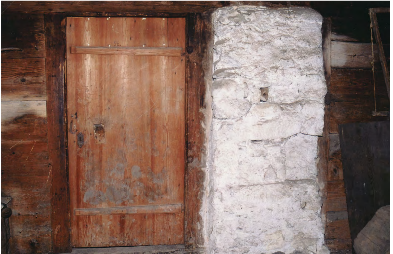
16 Buochs, Unter Feld: Küche, Blick auf die Stubentür und gemauerte Binnenwand. Im Mauerwerk ist die Position des früheren Ofenlochs zu erkennen, über welches der Stubenofen geheizt wurde. Dieser war zuletzt jedoch nicht mehr vorhanden. Blick nach Südwesten. Aufnahme 2000.
