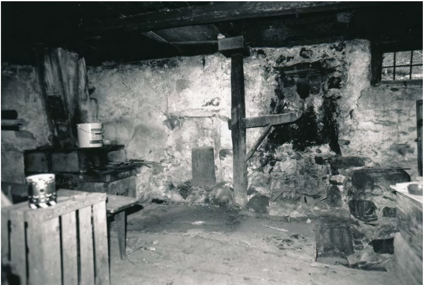
15 Buochs, Unter Feld: Küche, Blick auf die Südwand. Der Kunstofen mit Kamin auf der linken Seite kam erst im 19. Jahrhundert hinzu. Ursprünglich strich der Rauch durch die Öffnungen in der Nische und den offenen Dachraum ins Freie. Zum Zeitpunkt der Translozierung war die rechte Wandnische teilweise eingestürzt. Blick nach Südwesten. Aufnahmezeitpunkt unbekannt.
