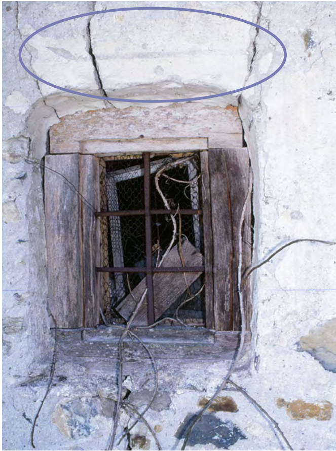
11 Buochs, Unter Feld: Fenster am Käsekeller. Trotz der Schäden am Putz waren Teile der aufgemalten Zierrahmen um die Fenster noch immer schwach nachvollziehbar. Mittels restauratorischer Untersuchung konnten Farbtöne und Putzzusammensetzung ermittelt und die Verzierung am Museumsbau rekonstruiert werden. Aufnahme 2000.
