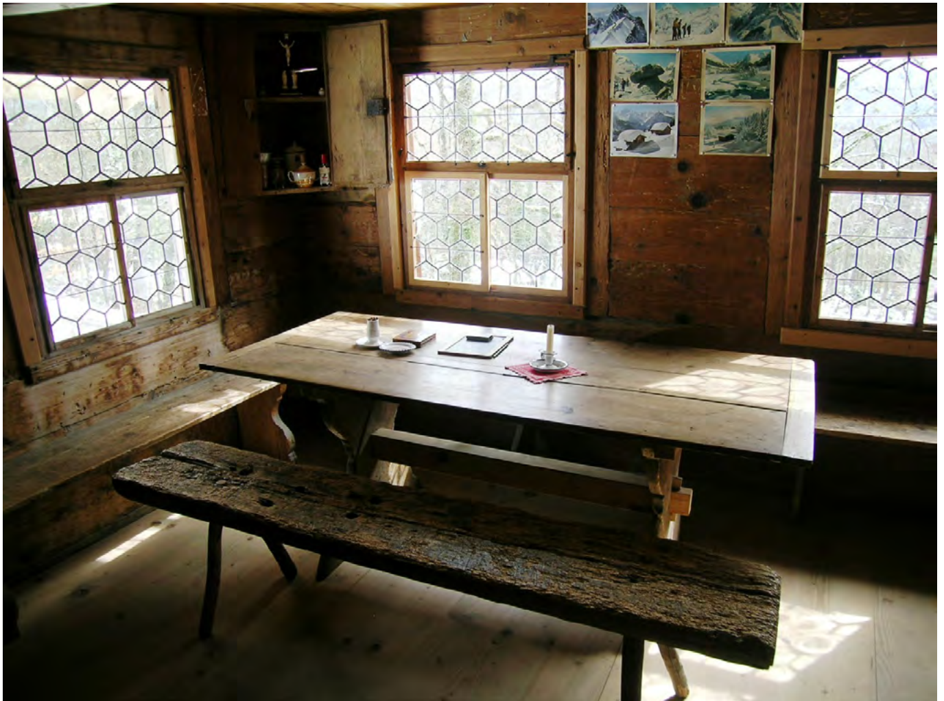
21 Freilichtmuseum der Schweiz, «Maiensässwohnhaus» aus Buochs: Sämtliche Stubenfenster haben eine dem Befund entsprechende Bleiverglasung erhalten. Das Eckkästchen und die Sitzbank wurden übernommen. Blick nach Süden. Aufnahme 2010.
