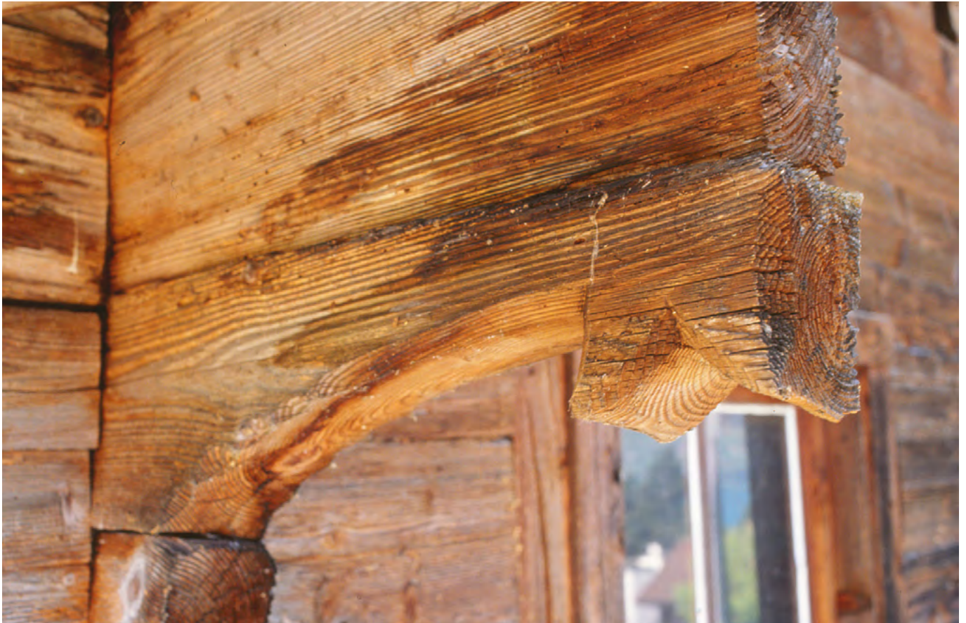
9 Buochs, Unter Feld: Die Blockkonsolen der Nordfassade waren mit einfachen Rossköpfen verziert, welche sich stilistisch in das 18. Jahrhundert zurückführen lassen. Blick nach Westen. Aufnahme 2000.
