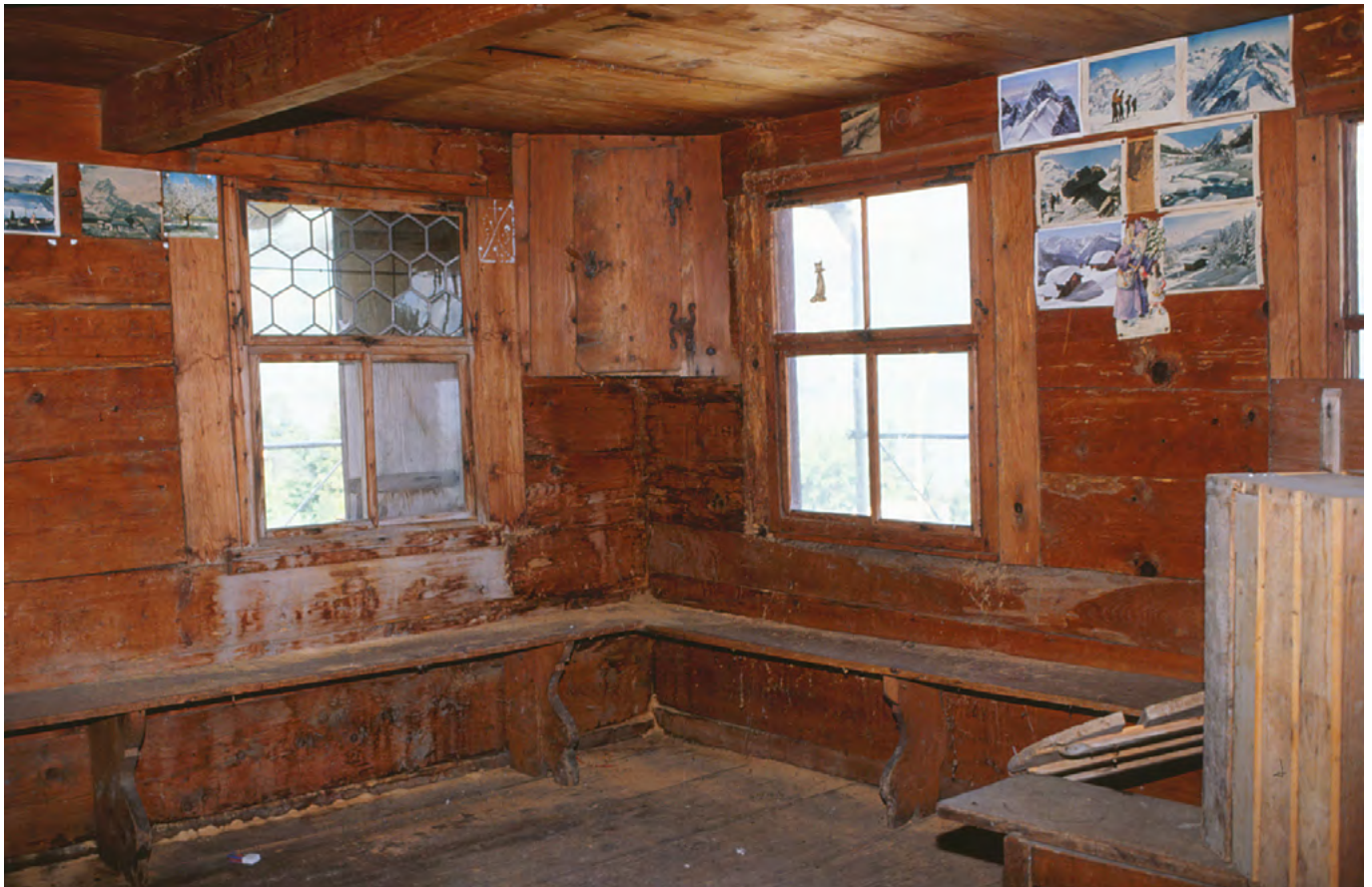
17 Buochs, Unter Feld: Stube, Nordwestecke. Die Bleiverglasung könnte aus der Erstbauzeit stammen. Einrichtungsgegenstände waren zuletzt nur wenige vorhanden. Eine Schlafstelle fehlte. Blick nach Norden. Aufnahme 2000.
