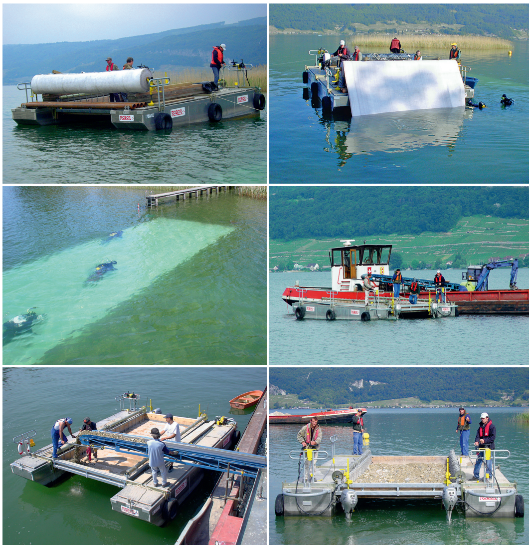
4 Sutz-Lattrigen, Hauptstation. Zwischen den Grabungsflächen wurden Bereiche mit guter Schichthaltung zum Schutz vor Erosion abgedeckt. Mithilfe des dafür entwickelten Katamarans wurden Geotextilmatten am Seegrund verlegt. Über diese wurde durch den aufklappbaren Boden des Katamarans zielgenau Kies geschüttet.
