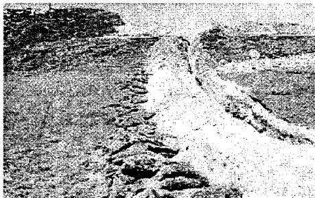
Abb. 6: Die Rasenziegel wurden sorgfältig abgehoben und separat gelagert, um sie nach der Schliessung des Leitungsgrabens sofort einpflanzen zu können.
