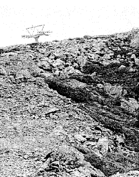
Abb. 5: Das Landschaftsbild sollte möglichst bewahrt werden. Deshalb wurden von den Bauarbeiten unberührte Inseln im Bauperimeter erhalten, von welchen aus sich nach Beendigung der Arbeiten die Vegetation wieder ausbreiten konnte.
