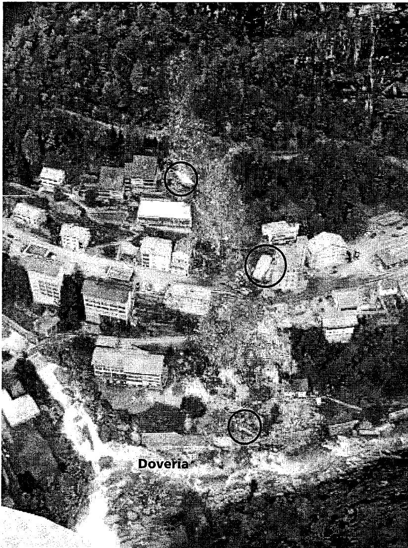
Fig. 29: Hangmure Gondo vom 14.10.2002. Aufnahme der Zerstörungsschneise. Oben im Wald die Schwergewichtsmauer des Blockfallverbaus zum Aufhalten der Steinschläge. Die drei abgerutschten Mauerteile von je 500 t sind je mit einem Kreis eingefasst: - das erste Mauerstück blieb nach ein paar Metern stecken. - der zweite Mauerteil zerschlug die Westfassade des Stockalperturms - das dritte Mauerstück durchschnitt das ganze Dorf und wurde erst bei der Doveria aufgehalten (Nach: www.crealp.ch ).
