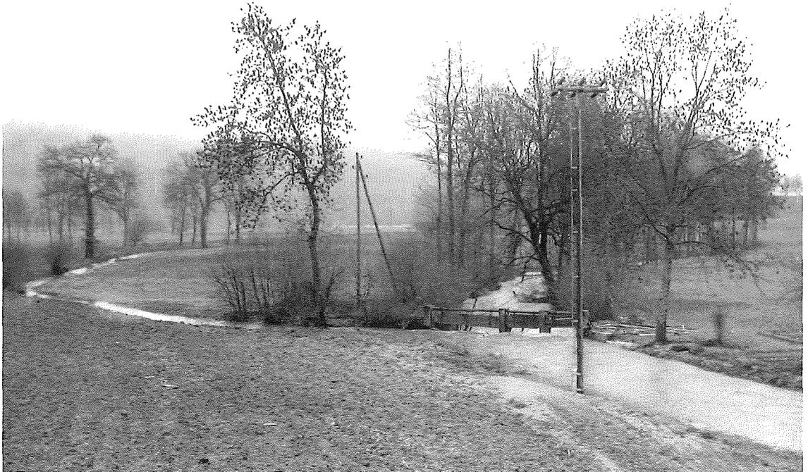
*Abb. 20: Brunnbachschwelli in den oberen Brunnmatten westlich Kaltenherberge. Der abgehende Hauptgraben ist trotz offener Schleuse vollgelaufen, da der Brunnbach Hochwasser führt*
