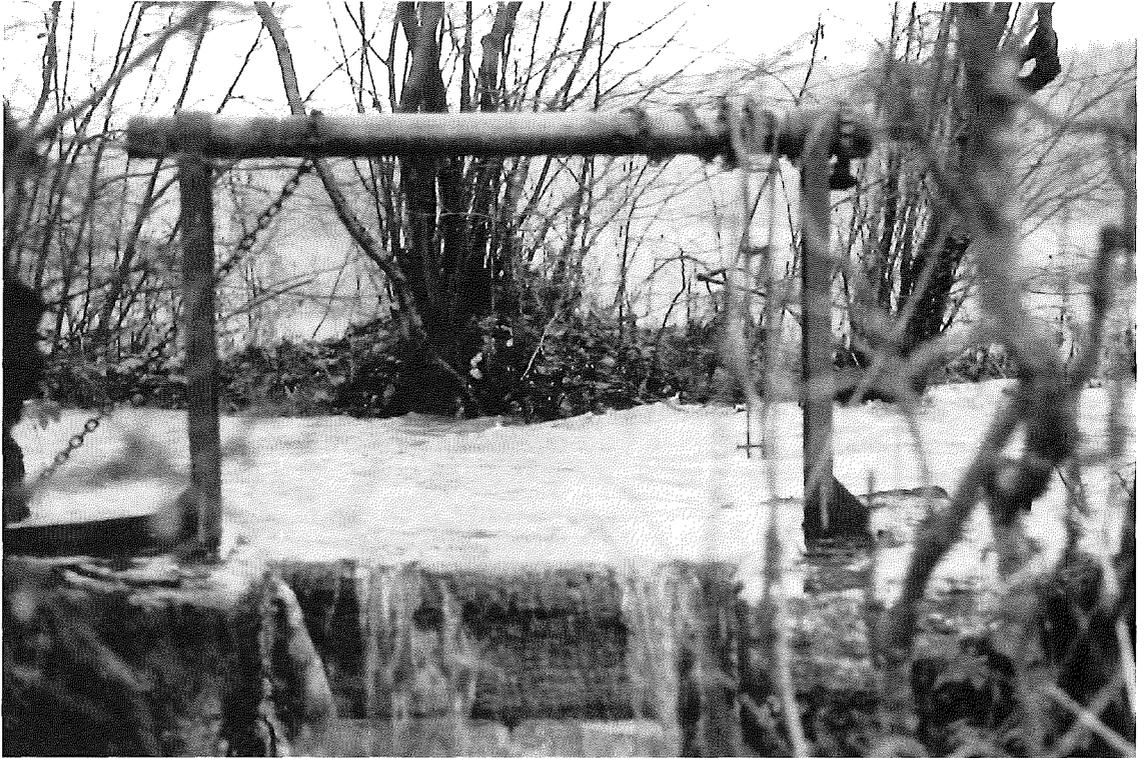
*Abb. 24: Seitenschleuse (Wüestimattschleuse) im Uferdamm des Langetenkanals unterhalb Langenthal. Hochwasserstand in der Langete. Ausuferndes Wasser wurde über die Bewässerungsgräben schadlos abgeführt*
