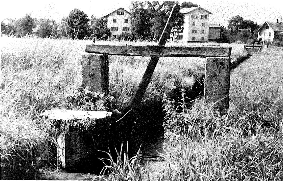
Abb. 7: *Auflassung des Bewässerungssystems im Langetental. Sie zeigte sich zuerst im beginnenden Verfall der Verteilereinrichtungen*
