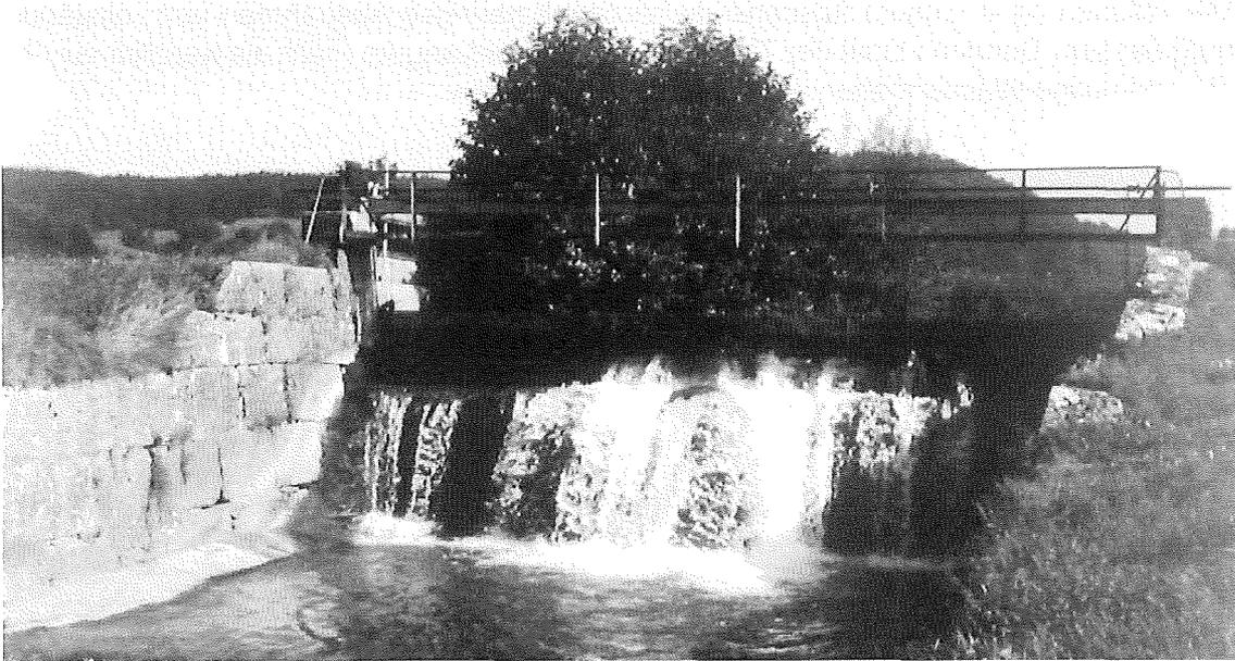
*Abb. 31: Mülischwelli oberhalb Lotzwil. Ansicht von der Unterwasserseite her. Sohlschwelle mit grosser Sprunghöhe und Ausbau der Widerlager in Naturstein*
