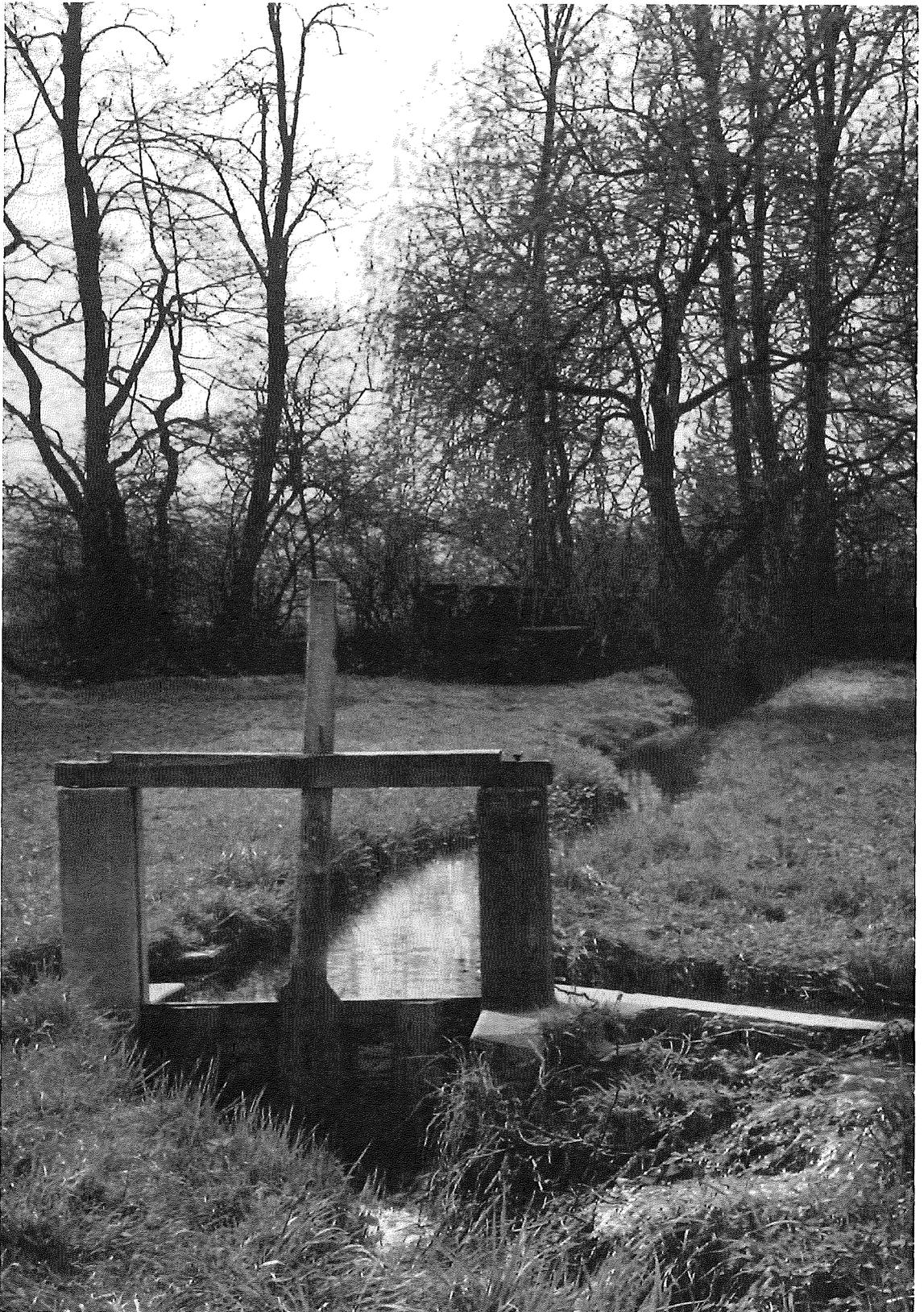
*Abb. 17: Stellfalle im Hauptgraben mit beidseitiger Wasserausleitung. Die Menge des Wassers kann nur stufenweise durch Fixieren der Schleusenhöhe im Joch geregelt werden. Ausbau mit Widerlager und Sohlschwelle*
