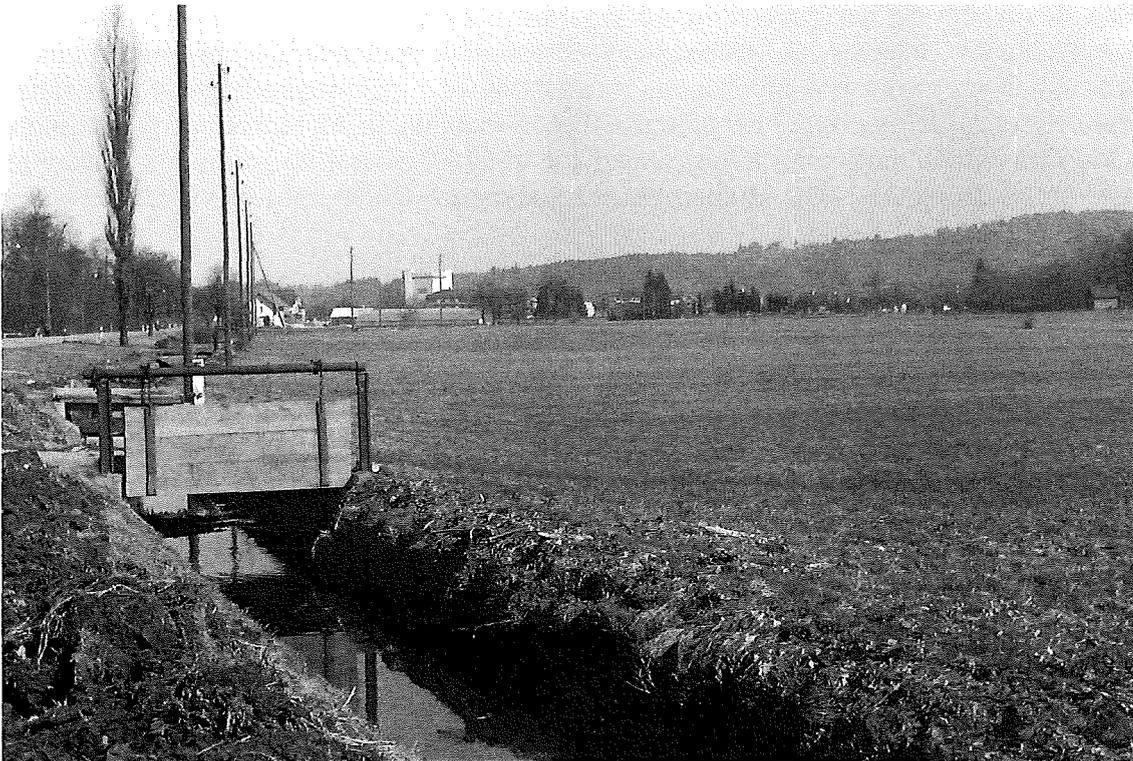
Abb. 10: Unterhalt der technischen Bewässerungseinrichtungen. Die Offenhaltung der Gräben gehörte zu den Pflichten der Wässerbauern (Fronarbeit). Frisch «geöffneter» Hauptgraben im Gruenholz, Roggwil
