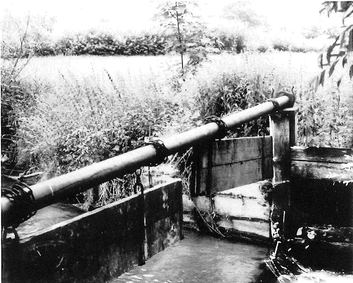
*Abb. 12: Stauschleuse (Schwelli) in der Langeten. Die geschlossenen Schützen liegen in der Sohlschwelle verankert*
