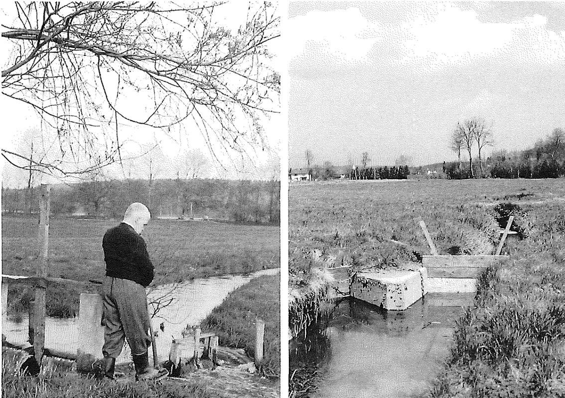
Abb. 18: Stechschütztypen zur Regelung der Wassermengen in den Bewässerungsgräben. Linkes Bild: Stechschütz in Seitengraben mit hölzernem Widerlager und Joch. Rechtes Bild: Stechschütz (Brütschli) in Seitengraben (rechts) und am Kopf eines Verteilergrabens (links), mit Widerlager, meist ohne Sohlschwelle. Fotos V. Binggeli, Bleienbach
