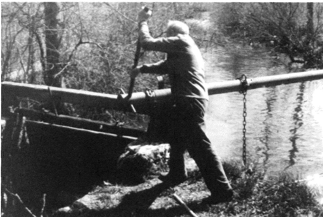
*Abb. 13: Geschlossene Stauschleuse und gezogene Seitenschleuse (Einlassschleuse). Das Aufziehen erfolgt hier mit einem Hebel, sonst auch mit Kurbeln oder Spindeln. Wäpischwelli unterhalb Lotzwil*
