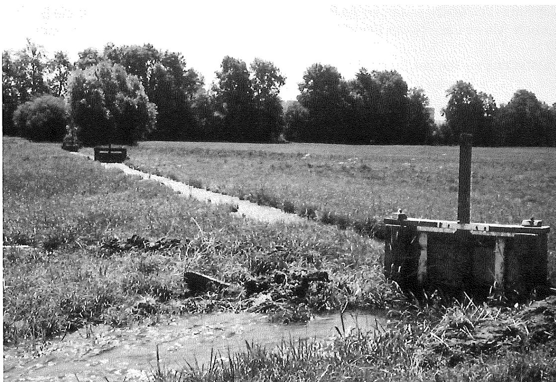
Abb. 27: Oberster Abschnitt des Steinachergrabens in den Schragenmatten unterhalb Langenthal. Hauptgraben mit Stellfallen. Aufnahme V. Binggeli, um 1970
