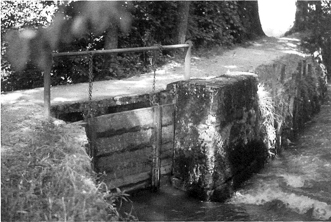
*Abb. 14: Seitenschleuse im Uferdamm der Langete. Das Wasser läuft bei offener Schleuse ohne Aufstau des Talbaches in den Bewässerungs-Hauptgraben*
