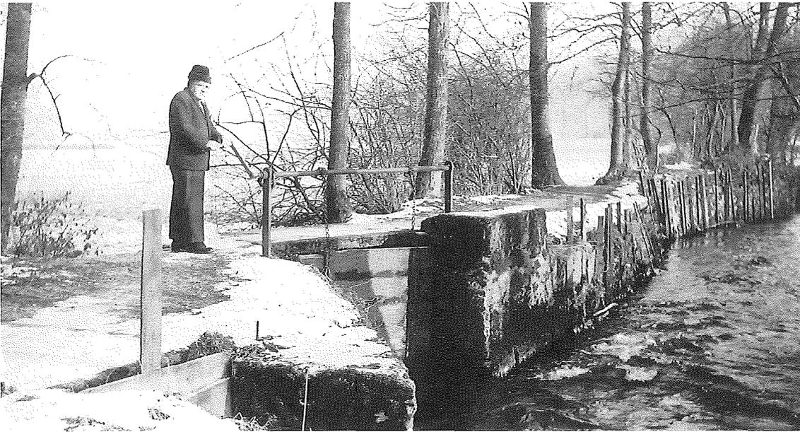
Abb. 11: Der Wässerbannwart zieht nach «alter Übung» die Steinacherschleuse in den Unteren Langenthaler Matten
