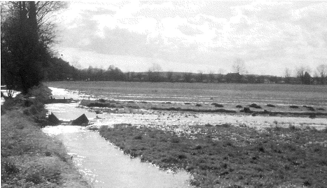
*Abb. 21: Bewässerung im Gruenholz bei Roggwil. Die Wasserverteilung erfolgt über Seitengräben, die rechtwinklig vom Hauptgraben abgehen. Ganz links im Bild ist der Langetenlauf sichtbar, dessen Sohle tiefer liegt als jene des Hauptgrabens (parallel zum Langetenlauf)*
