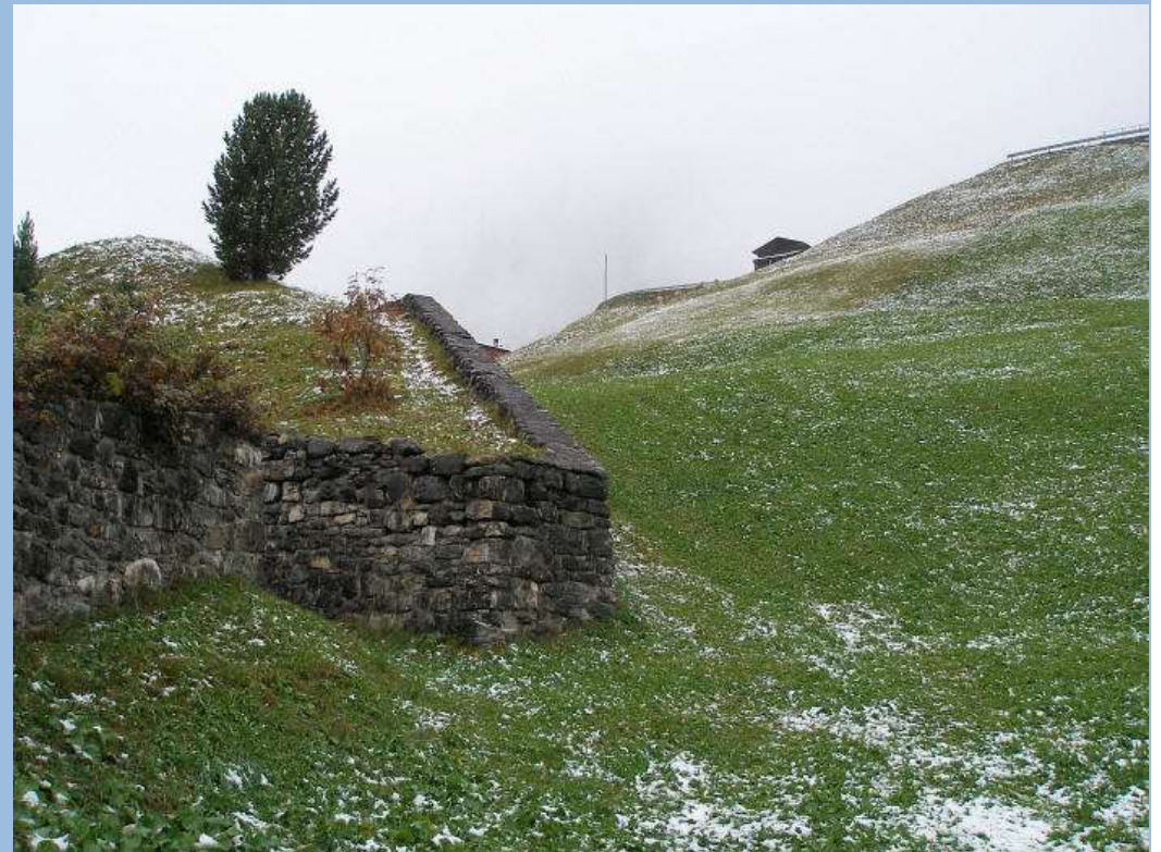
St. Antönien, Lawinenschutzmauer. Foto: SLF Davos
