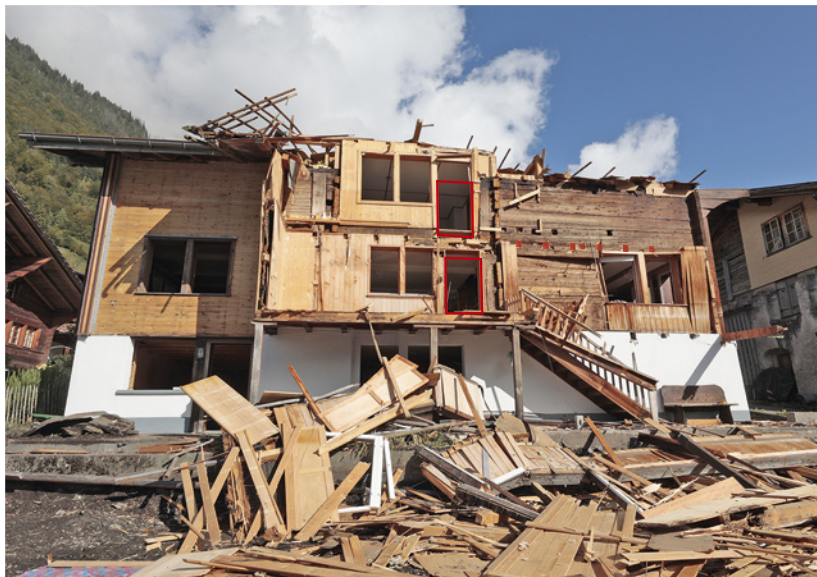
4 Oberried, Am Quai 43. Südfassade mit der Hauseingangstüre im ersten Wohngeschoss und der Laubentüre im zweiten Wohngeschoss. Im Rähm des ersten Wohngeschosses sind Ausnehmungen für die Stichbalken der Laube zu erkennen.
