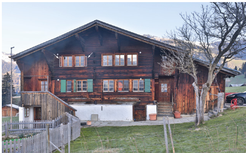
2 Saanen, Tüllerliweg 3. Südfassade. Rot: Links und rechts der linken Fensterreihe im zweiten Wohngeschoss sind die bauzeitlichen Fensterposten der Kammern zu erkennen. Blick nach Norden. Zustand April 2023.
