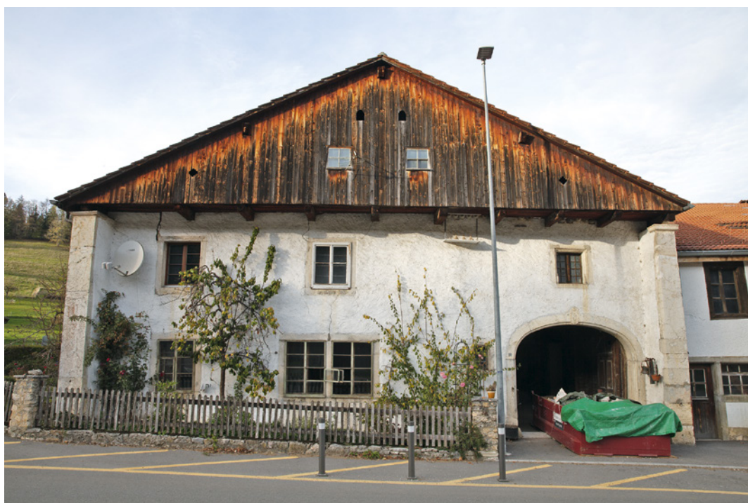
1 Petit-Val, Châtelat, Milieu du Village 4. Façade sud avec ses murs coupe-vent en pierre de taille ; les grandes baies et la porte de grange se rapportent à la phase 2. Vue vers le nord.
