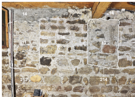
7 Saanen, Tüllerliweg 3. Keller 2: Mauer 6 (Abb. 6a) mit horizontalen Fugenstrichen und Brandspuren an den Mauersteinen sowie den im 17. Jahrhundert zugemauerten Schlitzfenstern 10 und 11. Blick nach Westen.
