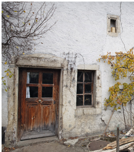
3 Petit-Val, Châtelat, Milieu du Village 4. Façade ouest. Porte de cuisine à linteau millésimé 1680 flanquée d'une fenêtre. Vue vers le sud-est.
