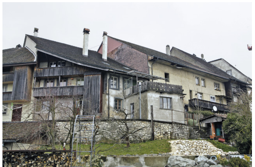
7 Wiedlisbach, Städtli 29. Ansicht der Südfassade mit dem Anbau (Raum 14). Blick nach Nordosten.
