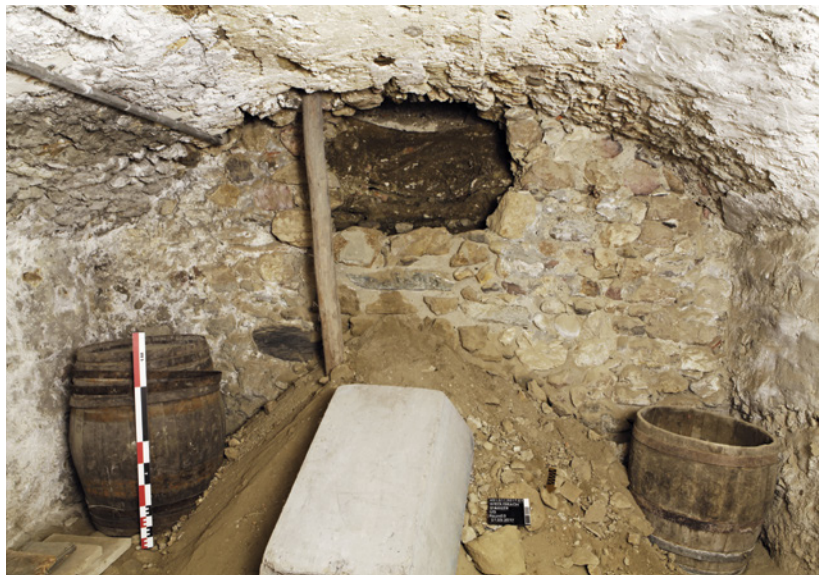
12 Wiedlisbach, Städtli 29. Keller 03. Blick nach Südosten.
