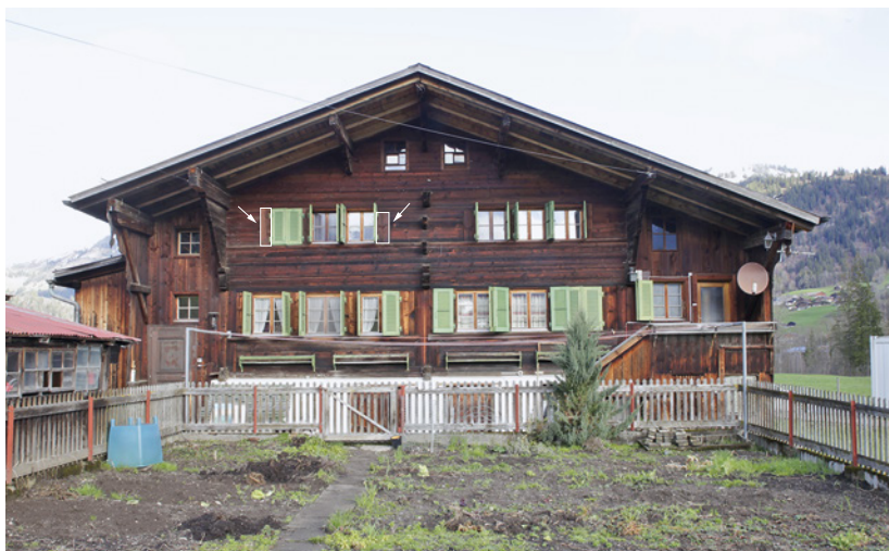
3 Saanen, Rübeldorfstrasse 112. Südfassade. Rot: Links und rechts der linken Fensterreihe im zweiten Wohngeschoss sind die bauzeitlichen Fensterposten der Kammern zu erkennen. Blick nach Norden. Zustand April 2023.
