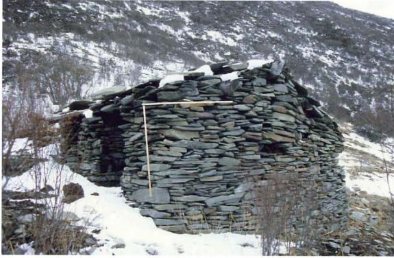
Abb. 99: Unterstand auf einer Yakweide, Trockenmauer (Kreis Xiaojin, 1993).
