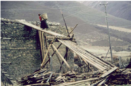
Abb. 120: Baurampe im Yilongsi. (1994)
