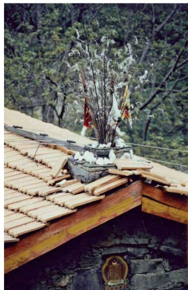
Abb. 111: Falzziegeldach mit Gebetsfahnen, Zweigen und weissen Quarziten am hinteren Firstende, rotgelb bemalte Windbretter und eingemauertem Zeichen der "Zehn Machtvollen" in der Giebelwand (bei Maerkang, 1993)
