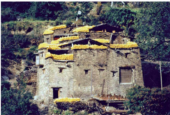
Abb. 109: eingebauter Speicher im Tal des Xiaoheishui. Zu beachten sind auch die Baunähte der flankierenden Erweiterungen (1995)
