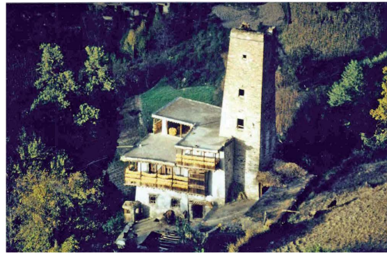
Abb. 60: an Wehrturm gebautes Haus bei Zhonglu im Kreis Danba
