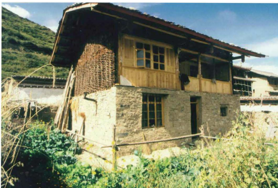
Abb. 103: Schutzwand aus Rutengeflecht bei einem Mönchswohnhaus in Songpan (1995)
