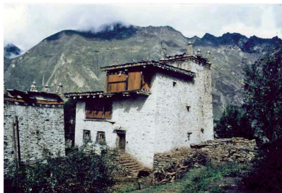
Abb. 62: abgebrochener Wehrturm bei Shuizi im Kreis Danba (1992)
