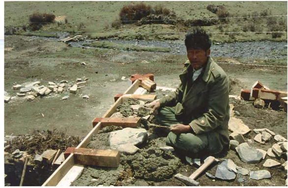
Abb. 232: Konstruktion eines Gesimes im Yilongsi (1994)
