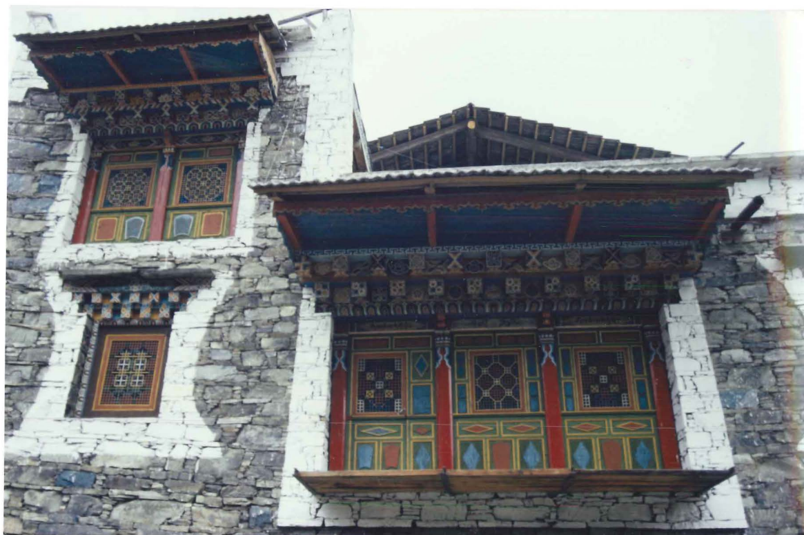
Abb. 200: Fensterwand bei Zuoqeqi (1993)
