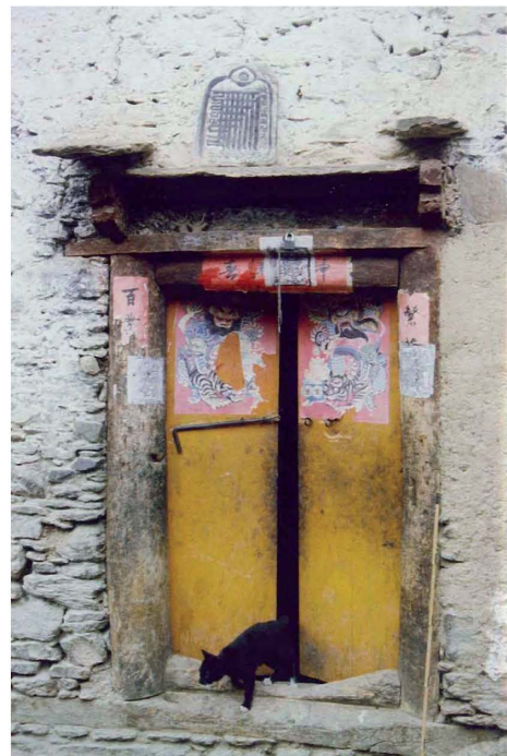
Abb. 162: Haus bei Suopo : Haustür (1992)
