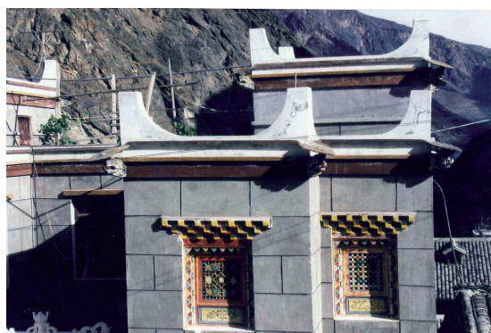
Abb. 79: modernes tibetisches Haus in Danba (1993) mit chinesischem Verputz und vorgetäuschten Steinfugen. Traditionell bleiben Fenster, Zinnen und Drachenköpfe an den Ecken
