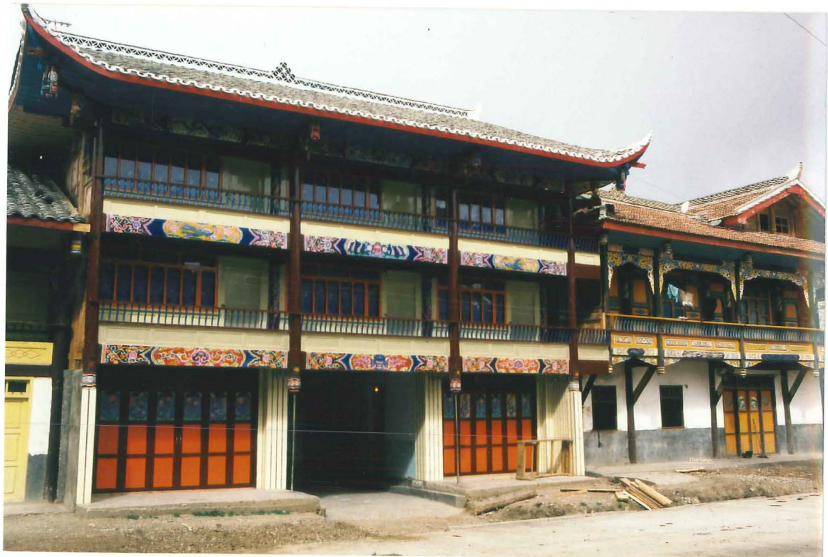
Abb. 277: Haus im östlichen Nachbartal bei Rewugou (1995)
