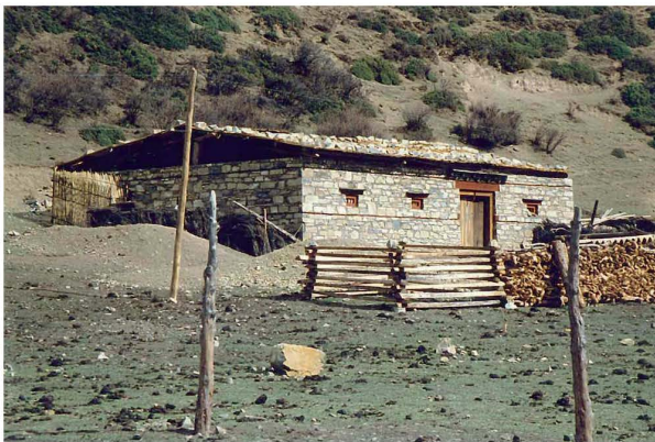
Abb. 239: Neubau in Ylongsi, der provisorisch mit nur einem Geschoss abgeschlossen ist (1994).
