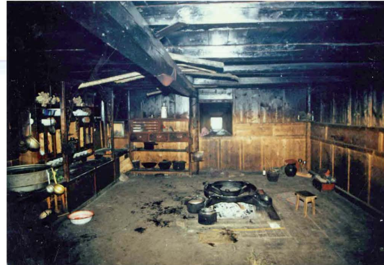
Abb. 295: Älteres Haus in Xiabazhai (1995). Die Mauer besteht rechts des Speichers aus Stein, links aus Lehm, der mit Brettern und Balken armiert wurde.
