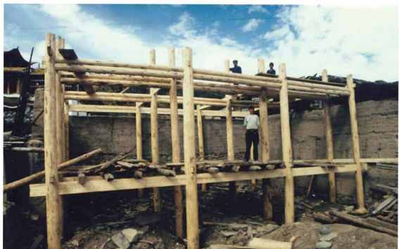
Abb. 104: Pfosten/Ständerbau mit Mantelmauer aus Lehm bei einem Mönchswohnhaus im Kreis Songpan (1995)
