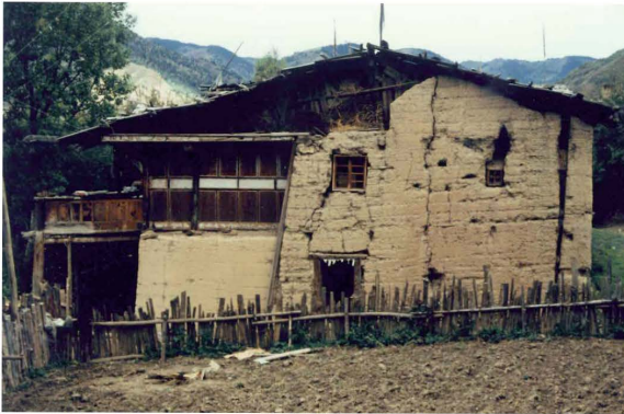
Abb. 101: Mantelmauer aus Lehm bei Rewugou (1995)
