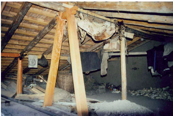
Abb. 187: Dachboden und Pfettenstützen bei Khati (Maerkang, 1993)
