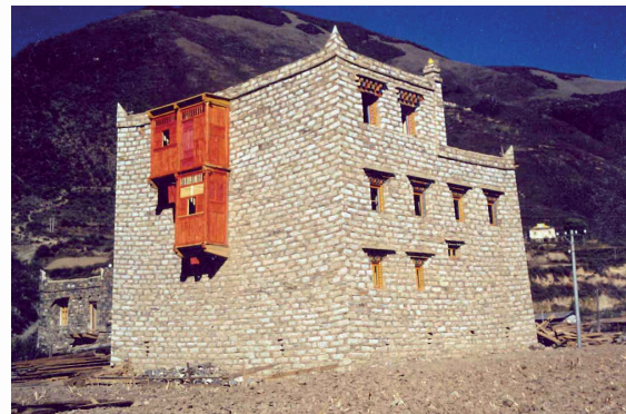
Abb. 190: Neubau mit Abort-Erkern an der Rückseite unterhalb von Maerkang (1995)
