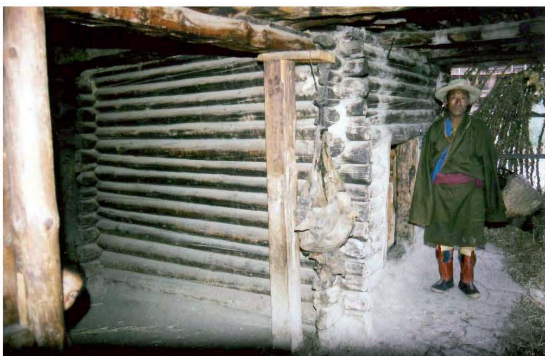
Abb. 110: Speicher in Blockbauweise im 2. Obergeschoss eines Steinhauses in Gamendi (1993)
