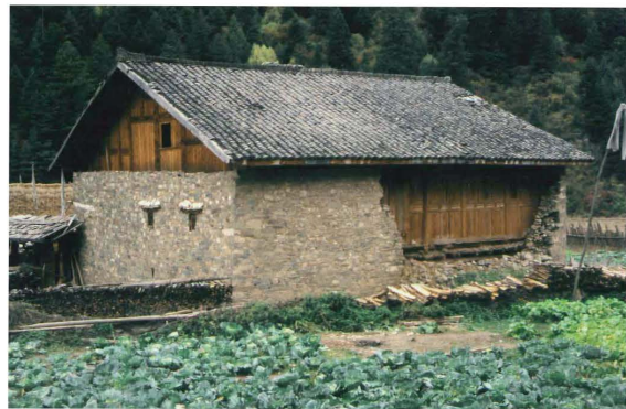
Abb. 102: Mantelmauer aus Stein bei Rewugou (1995)
