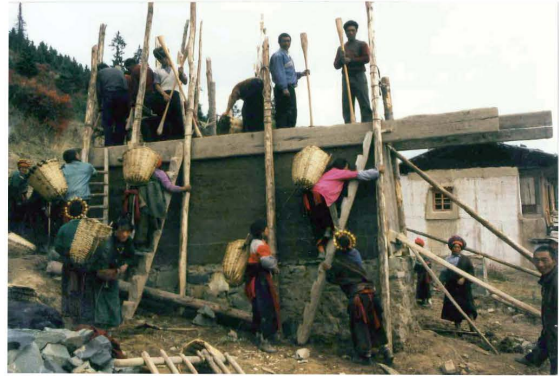
Abb. 100: Bau einer Lehmmauer bei Maoergai (1995). Die Frauen tragen die Erde in Hutten hinauf und schütten sie in die Verschalung, wo die Männern sie mit Hölzern feststampfen
