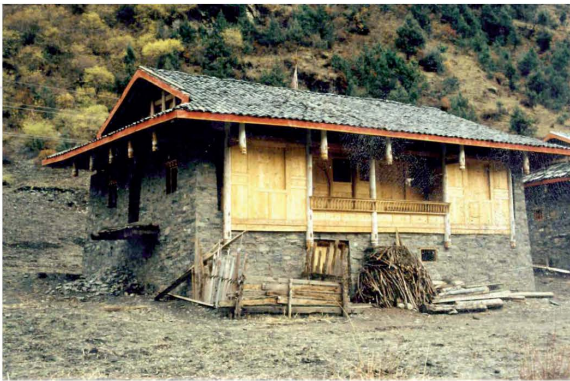
Abb. 294: moderner Neubau in Xiabazhai mit zwischengeschalteter Laube (1995). Der seitliche "Balkon" wird zum Aborterker ausgebaut.
