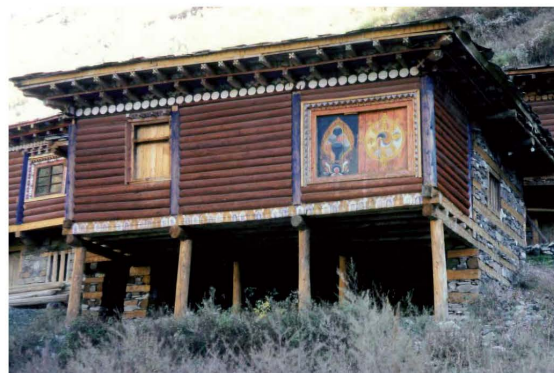
Abb. 115: Mischbauweise bei einem Mönchswohnhaus im Kreis Rangtang (1995)
