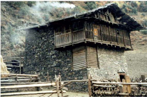
Abb. 296: Xiabazhai : aufgenommenes Haus mit eingebautem Getreidespeicher in Blockbauweise (1995)
