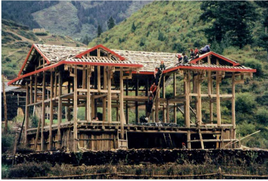
Abb. 266: Neubau chinesischer Konstruktion einer reicheren tibetischen Bauernfamilie in Sanlian westlich von Songpan (1995)
