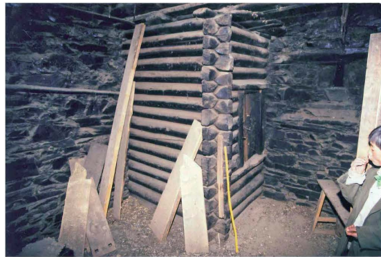
Abb. 297: Xiabazhai (1995): Speicher in Blockbauweise (R5)
