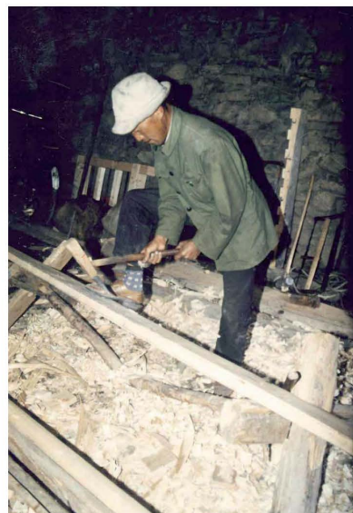
Abb. 123: Behauen eines Balken mit der Breitaxt (Zuokeyi, 1993)
