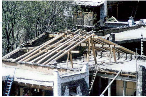
Abb. 188: Dachstuhl bei Maerkang (1993). Hinter der Firststütze ist der Bretterkamin erkennbar.
