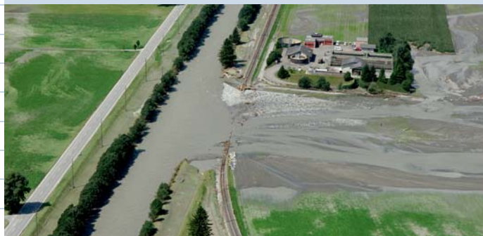
Abb. 9: Dammbrech an der Aare bei Meiringen BE beim Hochwasserereignis am 24. August 2005 (© Schweizer Luftwaffe)
