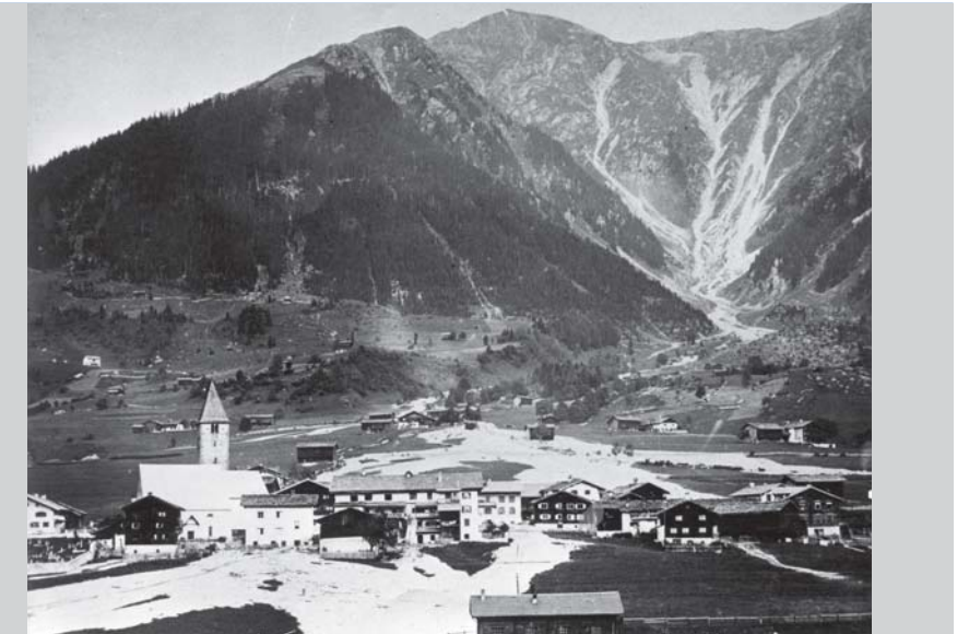
Abb. 1: Dynamische Überschwemmung und Murgang in Klosters Platz GR am 21. Juli 1900, im Hintergrund das Einzugsgebiet des Talbachs (Foto: Amt für Wald und Naturgefahren Graubünden)
